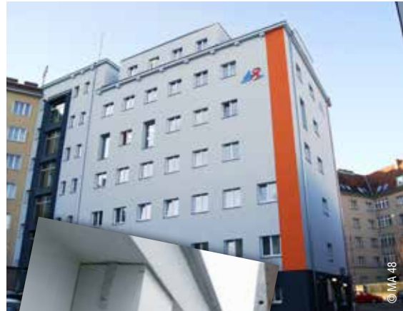
Das Amtshaus mit Nistkästen für Mauersegler
