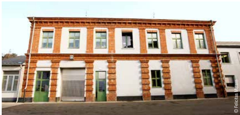
Neue Wärmeschutzfassade im Technik Center
