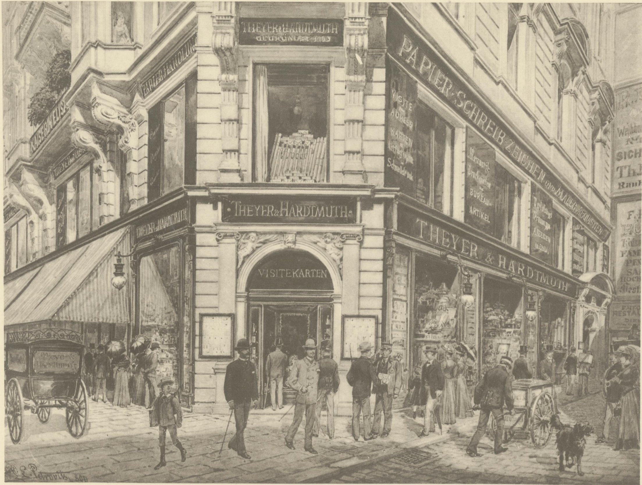
Das Geschäft von Theyer & Hardtmuth nach Umbau des Hauses 1886.
