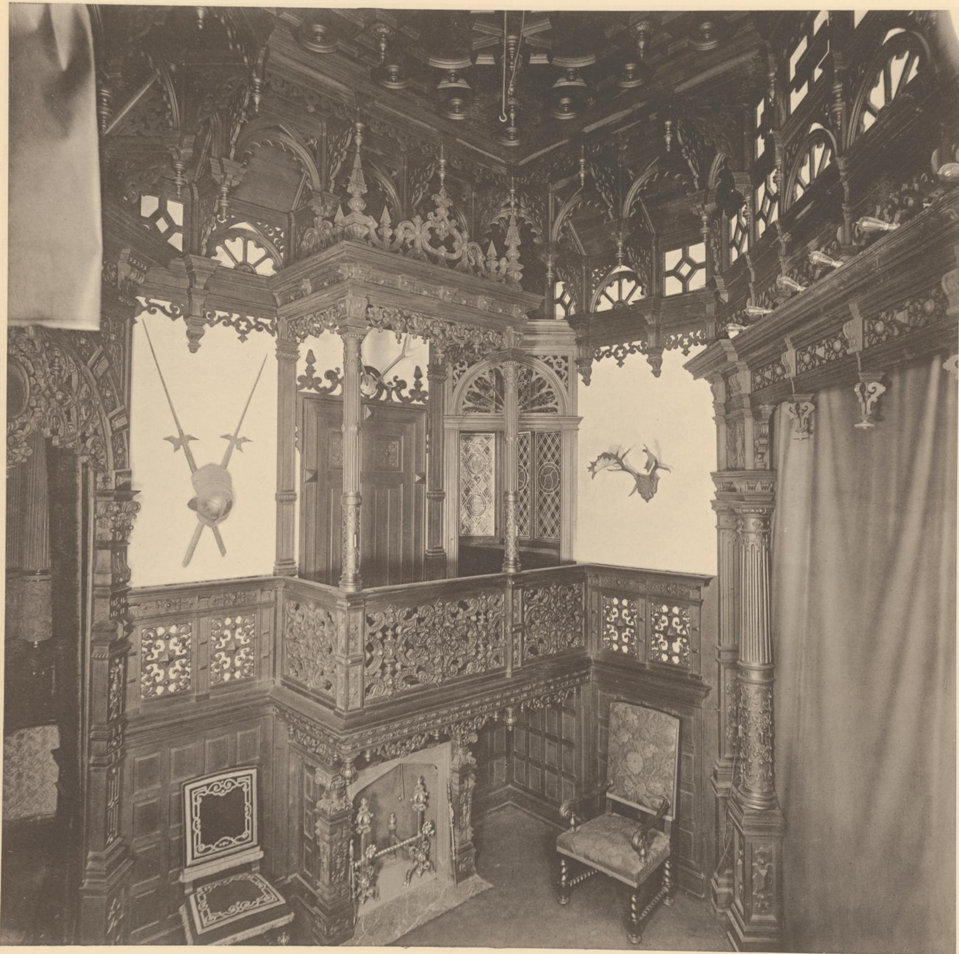
ECKE EINER GROSSEN HALLE STYL ENGLISCHE RENAISSANCE
