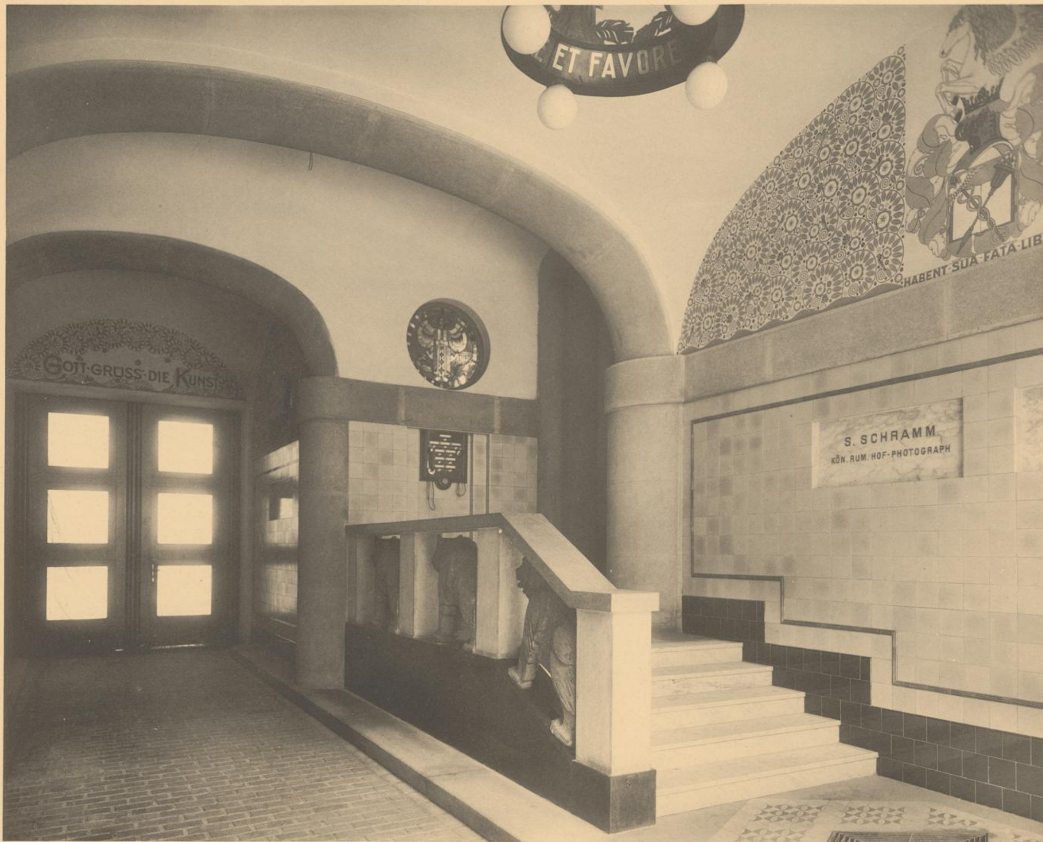
Architekt HANS PRUTSCHER.
