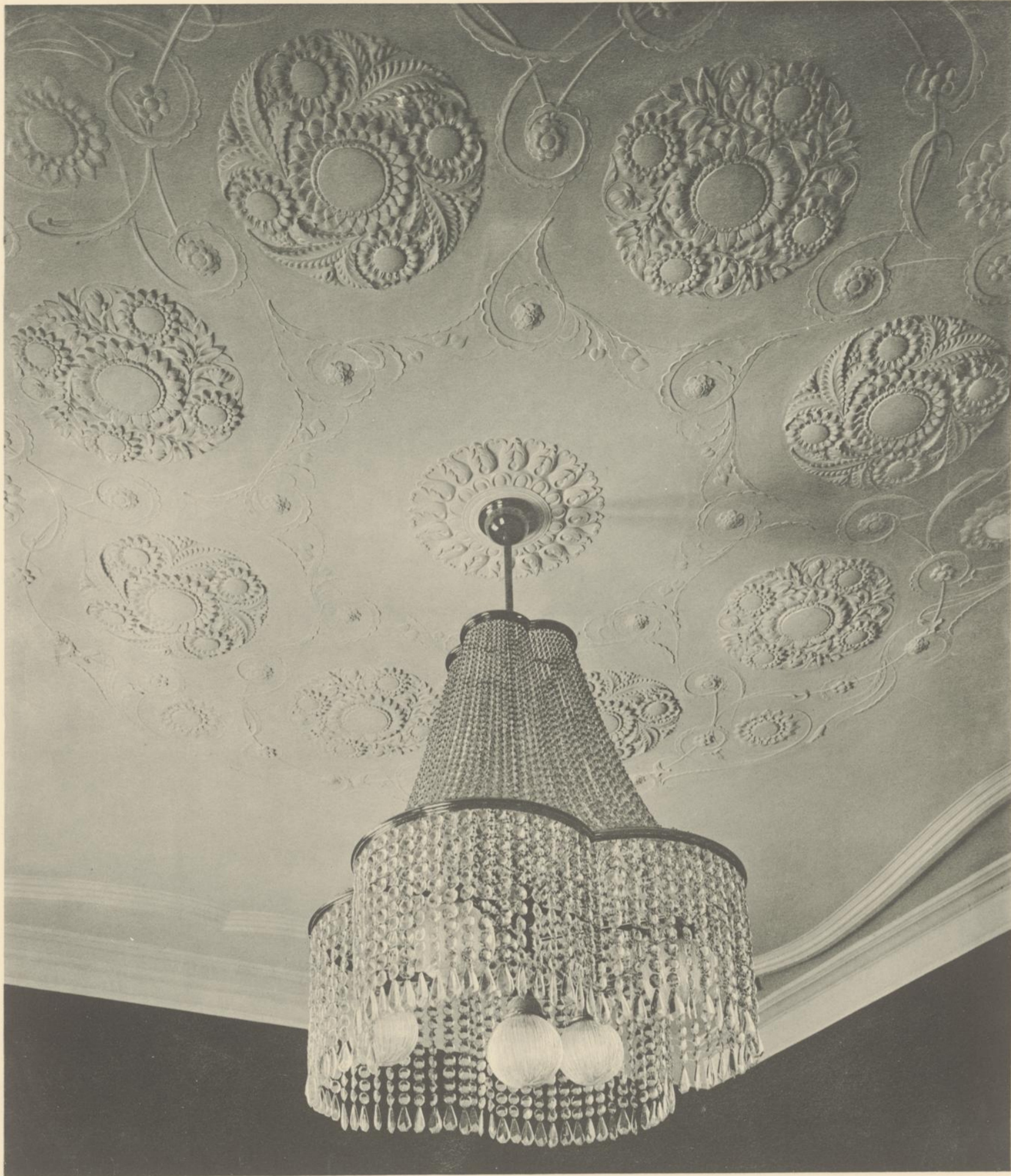
Handels- u. Gewerbekammer in Troppau: Stuckdecke und Luster.
