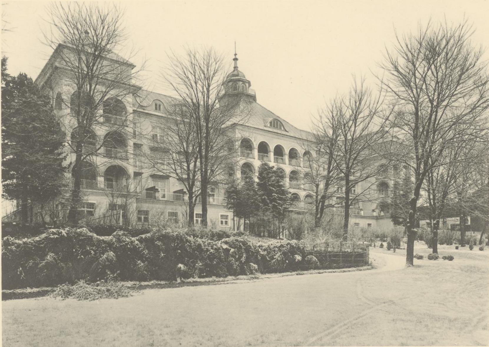
Prießnitz-Sanatorium Gräfenberg: Südansicht.
