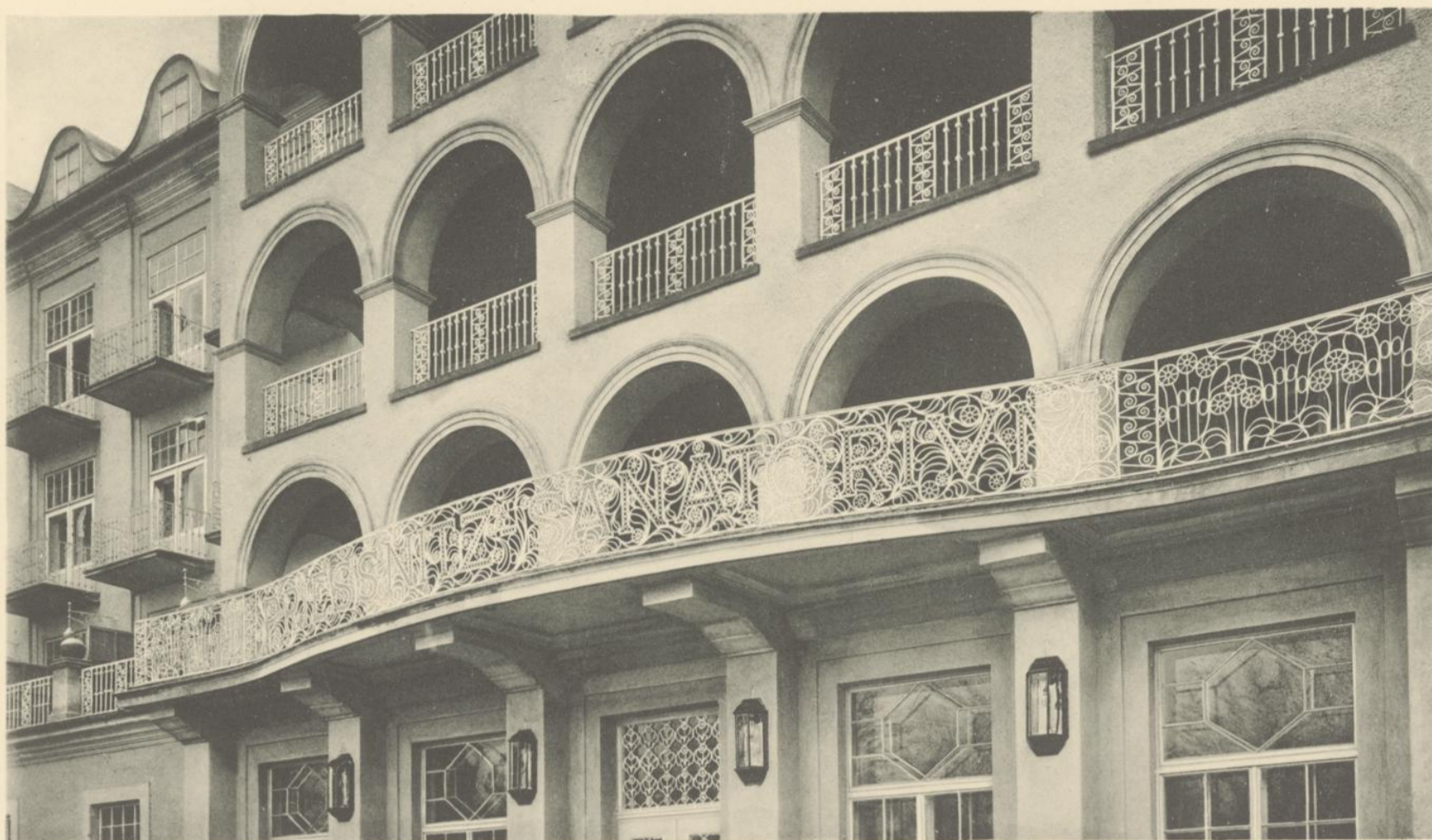
Prießnitz-Sanatorium Gräfenberg: Detail der Fassade.
