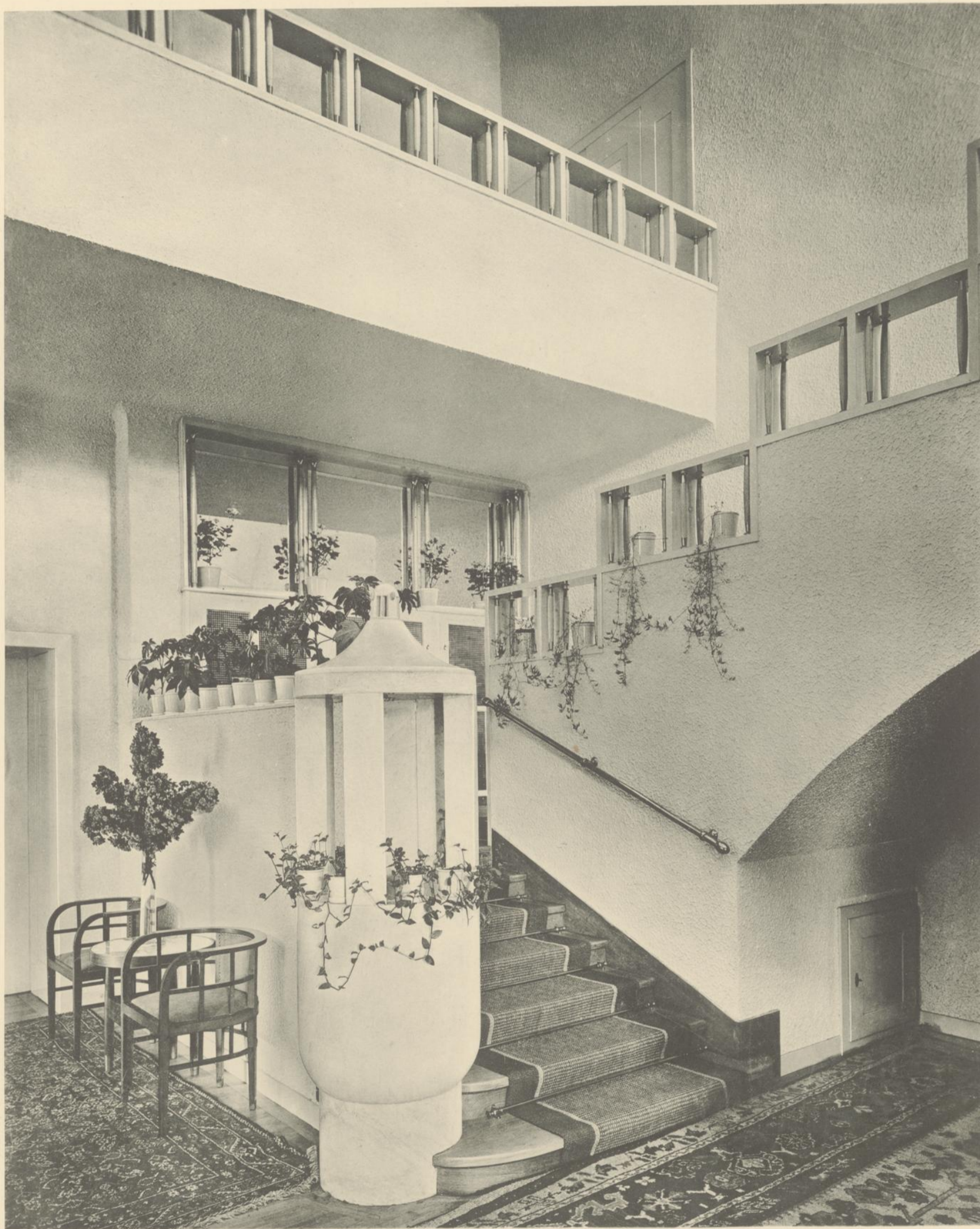
Villa Kurz: Stiegenhaus.
