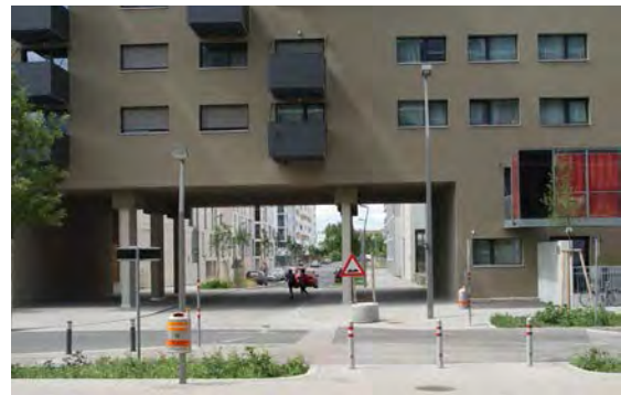
Abbildung 33: Baublock Nordbahnhof E – Durchbruch im Erdgeschoß
