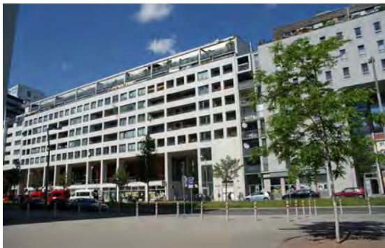
Abbildung 18: Baublock Nordbahnhof C – Zeile an der Vorgartenstraße, Durchgänge
