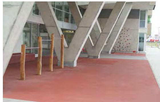
Abbildung 69: Baublock Nordbahnhof O – Spielbereich
