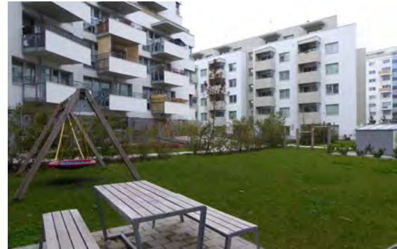
Abbildung 99: Baublock Hauptbahnhof C – Kinderspielplatz
