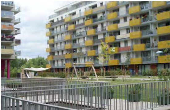
Abbildung 51: Baublock Nordbahnhof J – Freiflächennutzung
