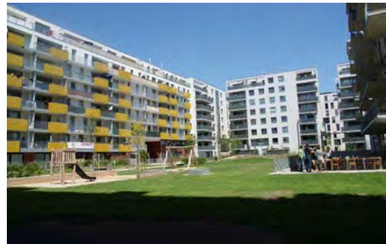
Abbildung 52: Baublock Nordbahnhof J – Freiflächennutzung
