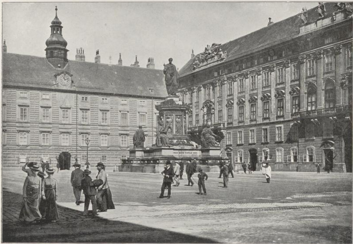
INNERER BURGPLATZ. REICHS-KANZLEIPALAST VON FISCHER VON ERLACH. KAISER FRANZ-DENKMAL VON MARCHESI.
