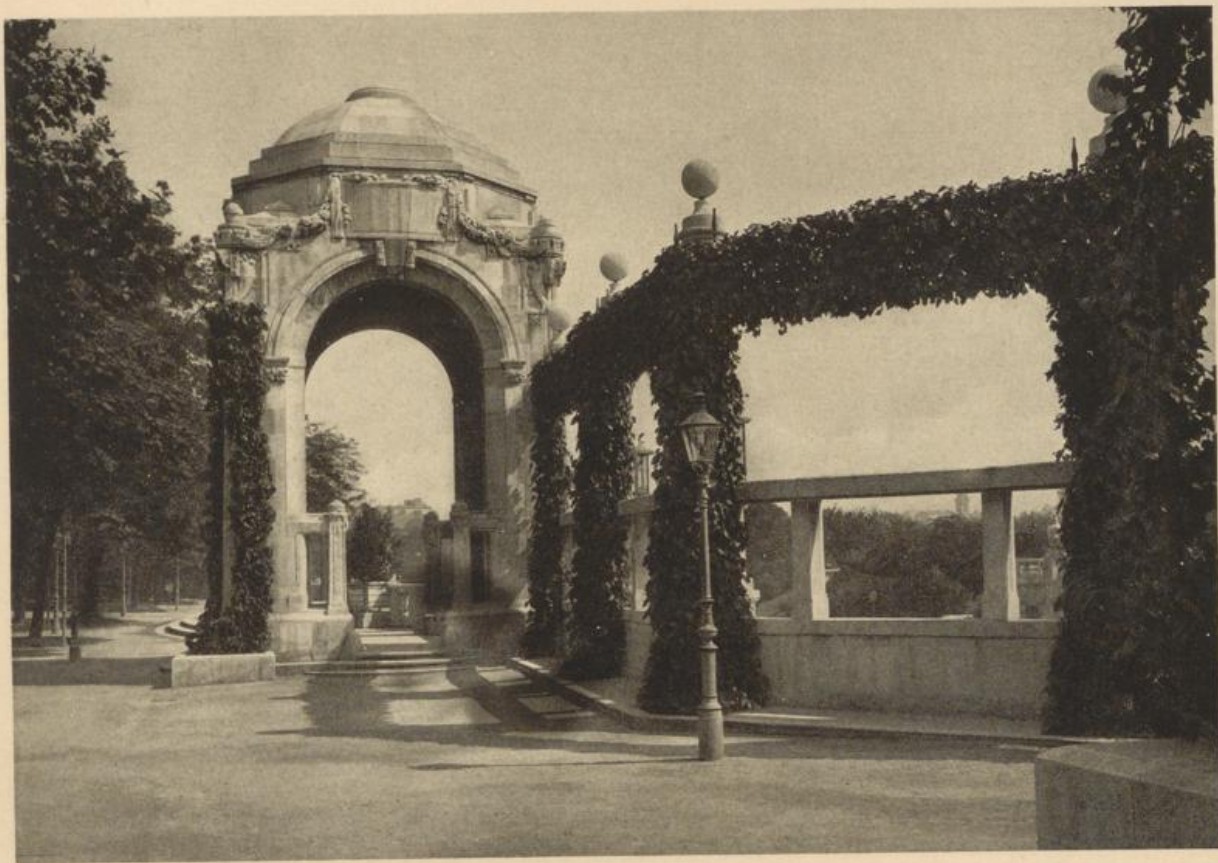
EINWÖLBUNGSENDE DES WIENFLUSSES IM STADTPARK. (Erbaut von F. OHMANN und HACKHÖFER.)
