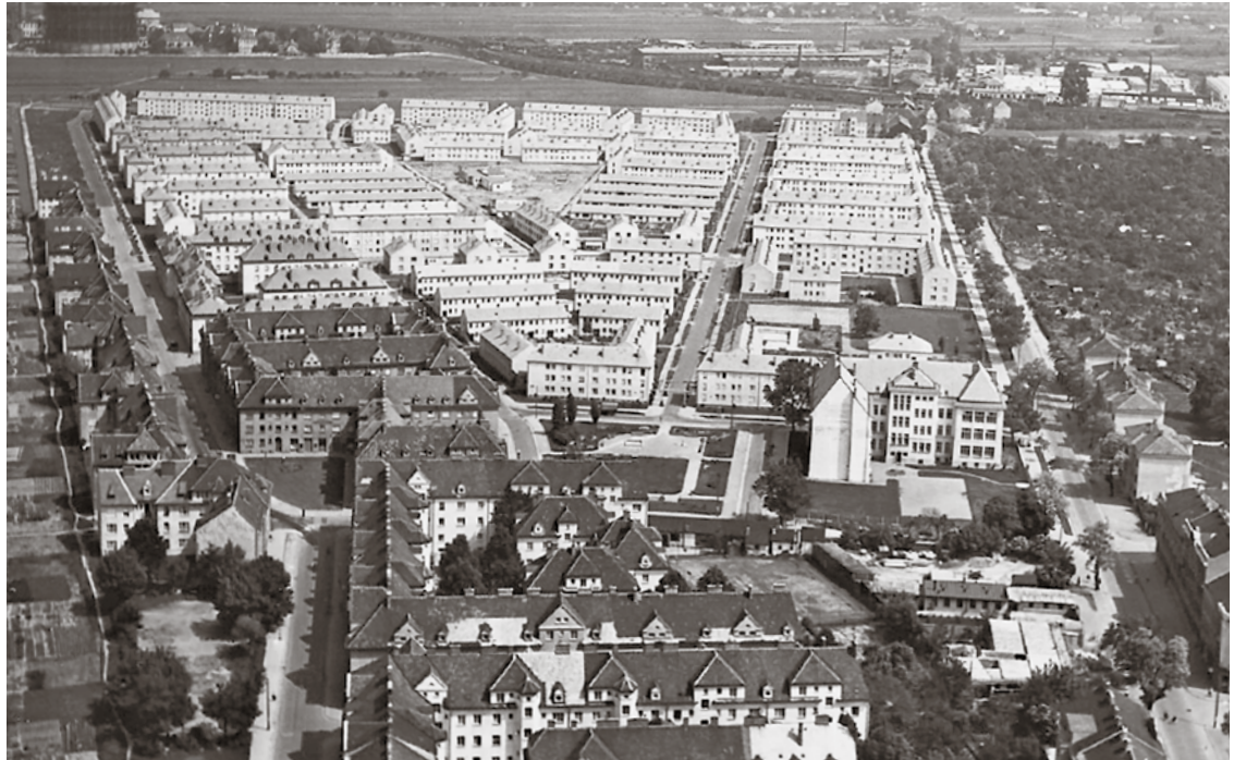
Die Siedlung Siemensstraße wurde nach Plänen von Franz Schuster errichtet.
