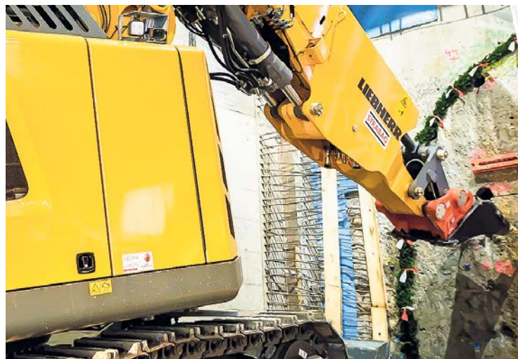
Mit einem Spezialwerkzeug gräbt sich der Bagger durch den Untergrund.
