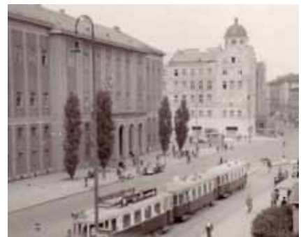
Abb. 5: Foto vor Abbruch
