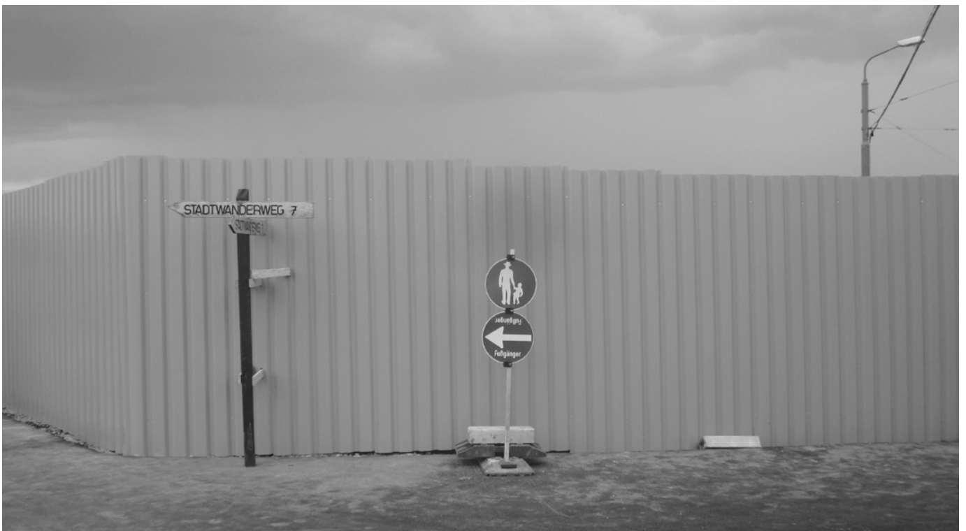
Baustelle U-Bahn-Linie U1 am Verteilerkreis Favoriten
