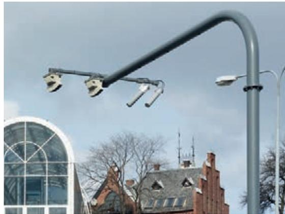
Einfacher Träger mit elektronischen Geräten zur Erfassung aller Fahrzeuge, die den Osloer Mautring passieren.
