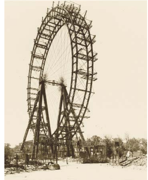
Im Jahr 1944 beschädigte ein Bombentreffer das Riesenrad schwer, alle 30 Waggons brannten aus.
