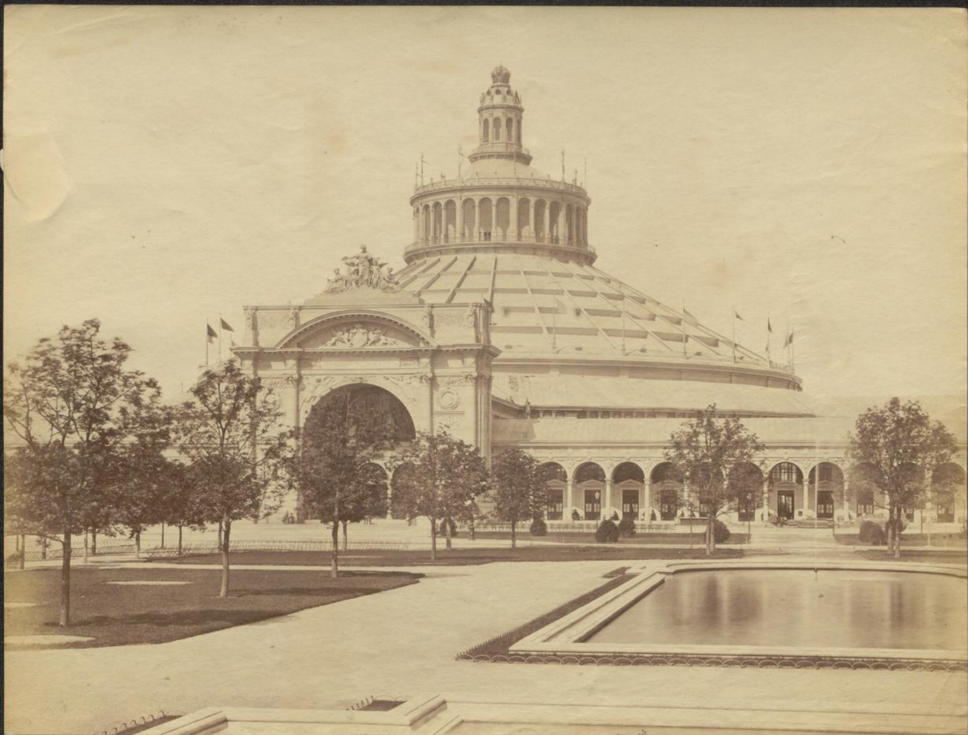
Nr. 162. Das Südportal mit der Rotunde.
