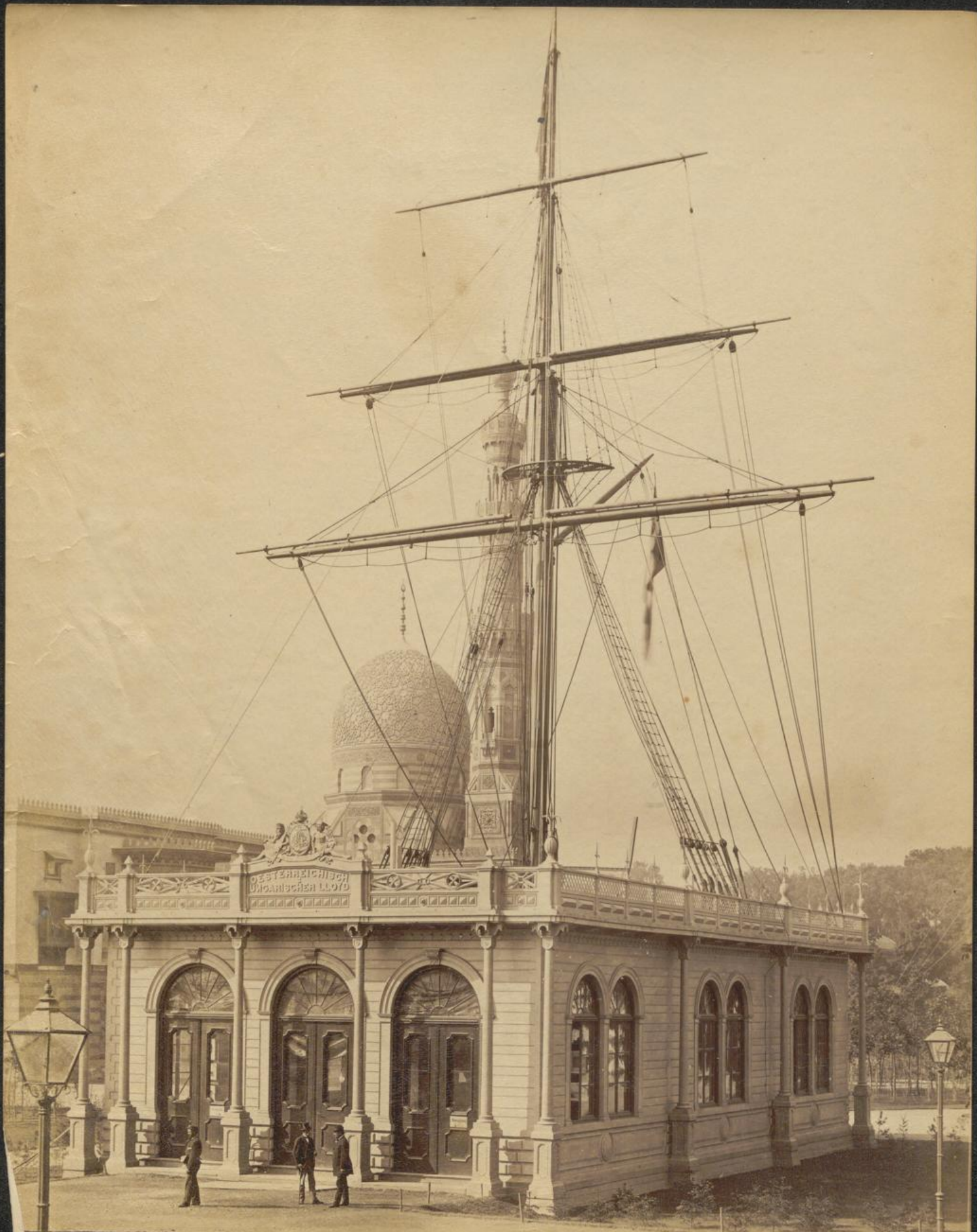
Nr. 560. Pavillon des Oesterr. Ungar. Loyd.
