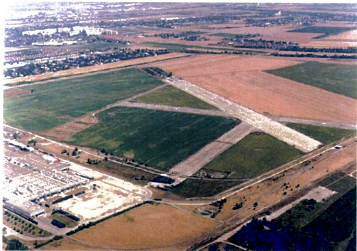
Abb. 1: Aktuelles Luftbild des ehemaligen Flugfeldes Aspern
