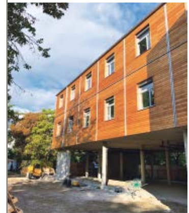
Der Zubau in Modulbauweise erfolgt bei laufendem Betrieb.
