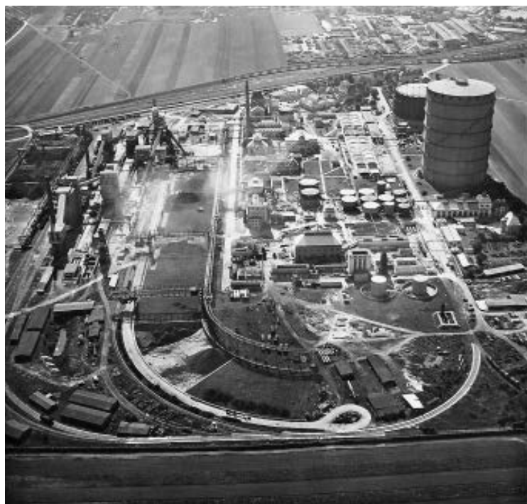
Das Gaswerk Leopoldau (Foto 1956) wurde 1909 erbaut.
