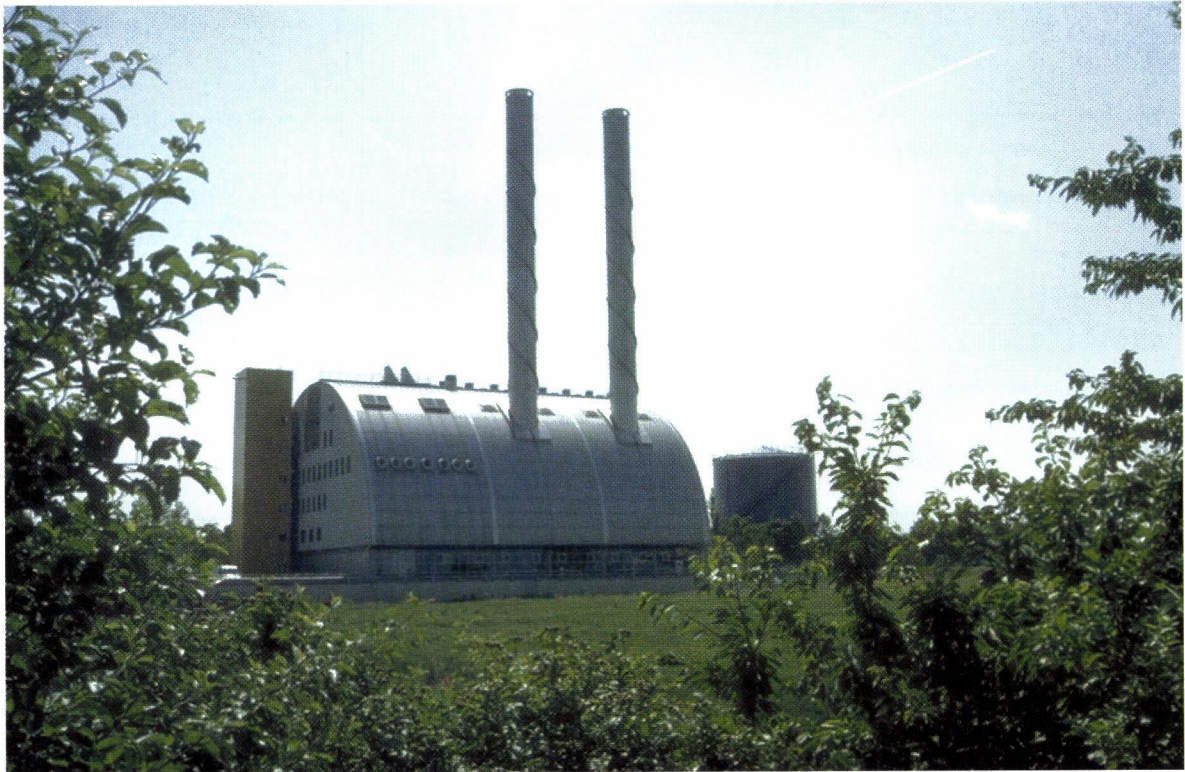
Abbildung 9: Fernwärmewerk Wien Süd
