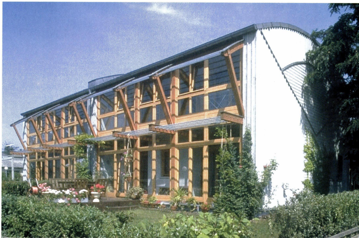
Abbildung 24: WBSF – Neubau 22 Kamillenweg
