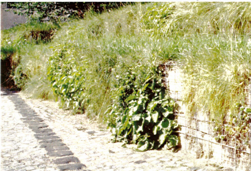
Gabionen begrenzen den Erdwall. Pflasterbänder unterstreichen die räumliche Zonierung des Gartenhofes
