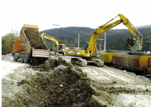
Lainzer Tunnel: Aushubtransport per Bahn
