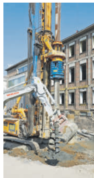
Schwer ist das Bohrpfahlgerät, das die Arbeiten für das Fundament des zweigeschoßigen Aufbaus ausführt.
