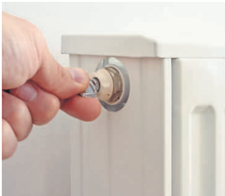
Am Beginn der Heizsaison sollten alle Heizkörper entlüftet werden.
