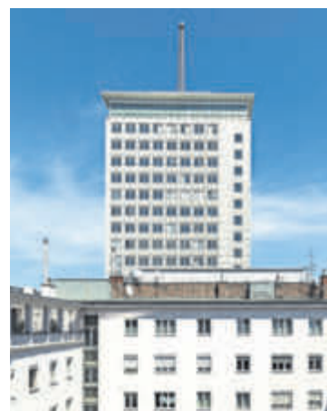
Der 73 Meter hohe Ringturm von Architekt Erich Boltenstern wurde zwischen 1953 und 1955 erbaut.
