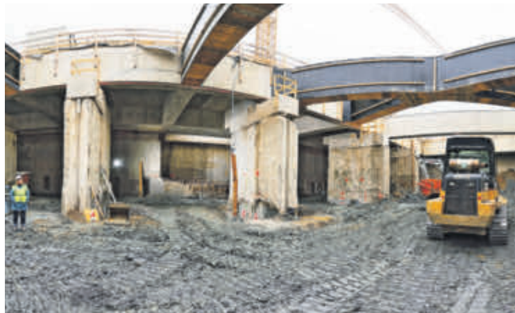
Am Linienkreuz U2xU5 wird fleißig gebaut, unter anderem auf dem Matzleinsdorfer Platz, bei der Station Rathaus und beim Frankhplatz.
