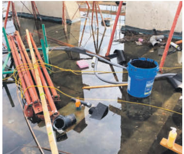
Vom mangelhaft ausgebauten Dachboden kann das Wasser nicht abfließen und sickert durch die Decke in die darunterliegenden Wohnungen.
