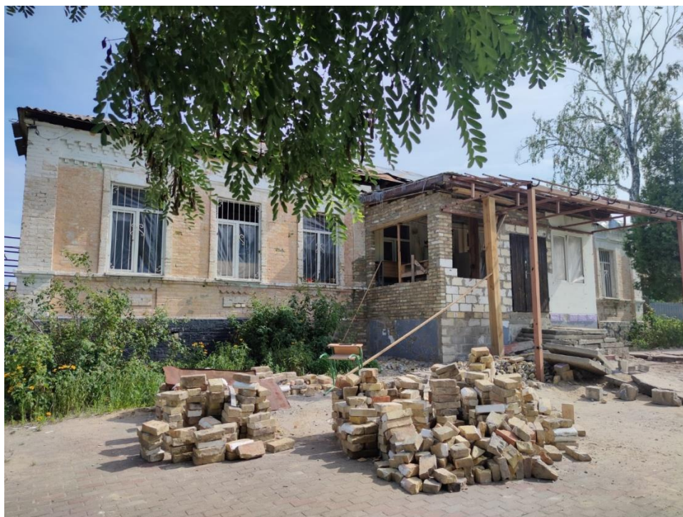
Sanierung der kriegszerstörten Volksschule in Hostomel, Region Kiew. Foto: ÖB Kiew
