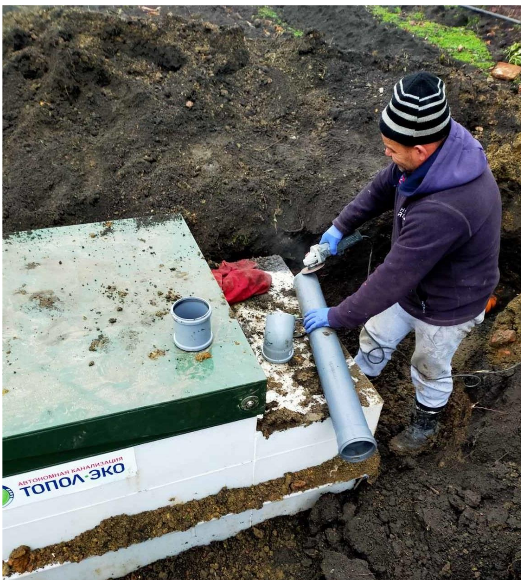
Errichtung einer Kläranlage. Foto: Concordia
