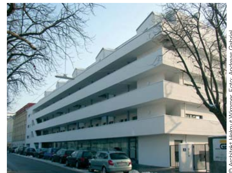
© Architekt Helmut Wimmer, Foto: Andreas Göttrich
