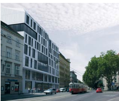
© NMPB Architekten ZT GmbH
