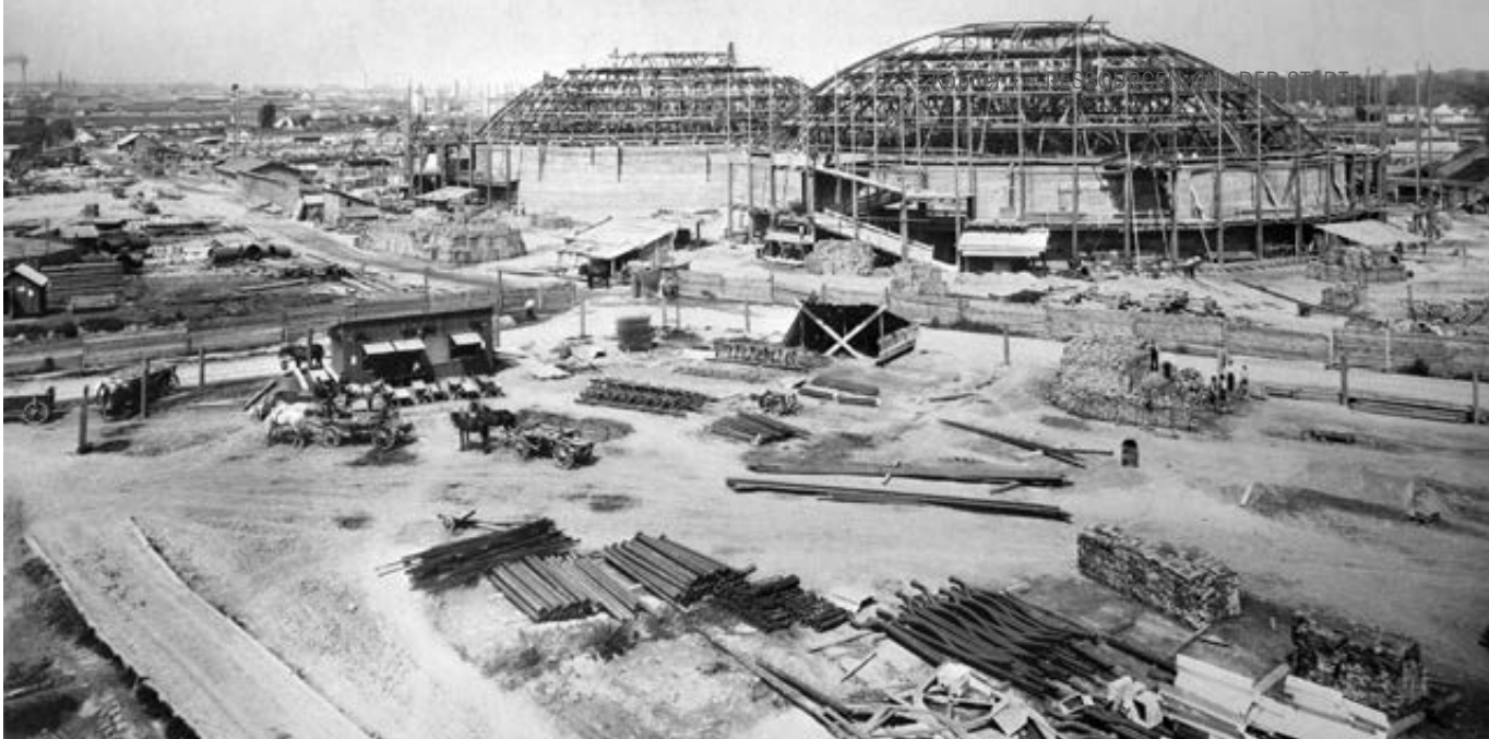
Baustelle Gasometer Simmering 1897 © Wien Energie Gasnetz
