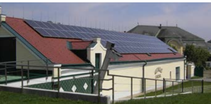
Photovoltaikanlage am Weingut Cobenzl © MA 20 - Energieplanung
