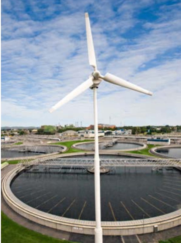
Projekt SternE, Strom aus erneuerbaren Energien © Staudacher, ebswien
