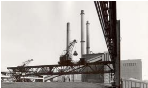
Kohlelager Kraftwerk Simmering 1967 © Josef Kratky, Wien Energie
