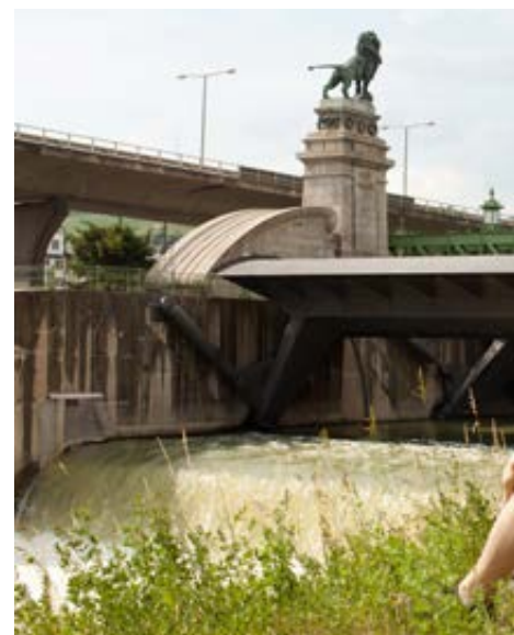
Wasserkraftwerk Nussdorf © Ian Ehm, Wien Energie
