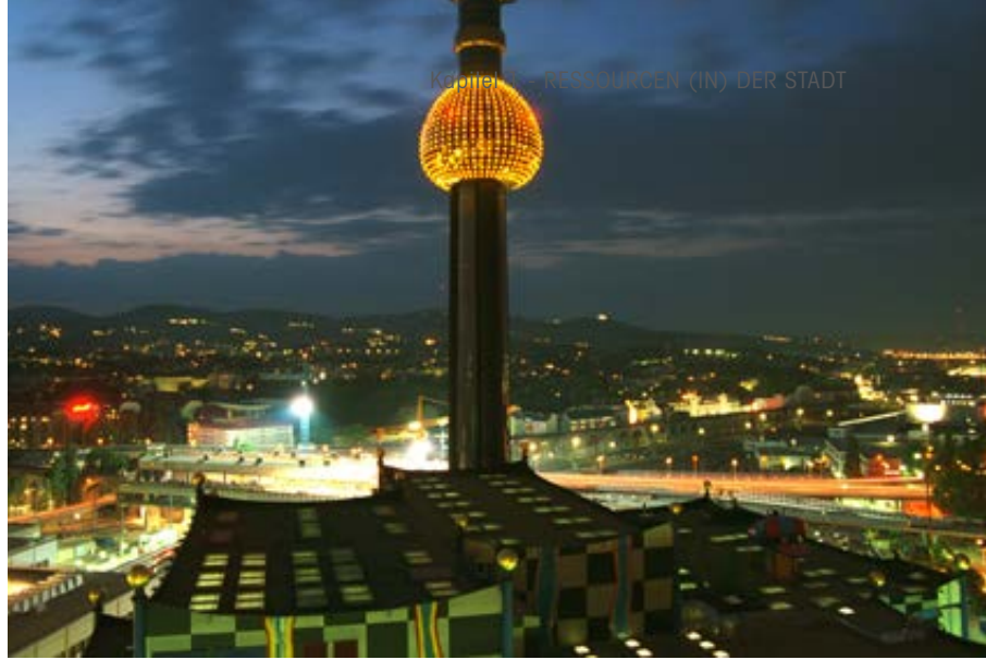
Thermische Abfallbehandlungsanlage Spittelau © Ernst Schauer, Wien Energie Fernwärme
