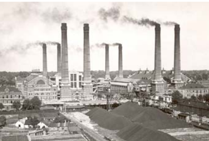
Kohlelager Kraftwerk Simmering 1926 © Josef Kratky, Wien Energie
