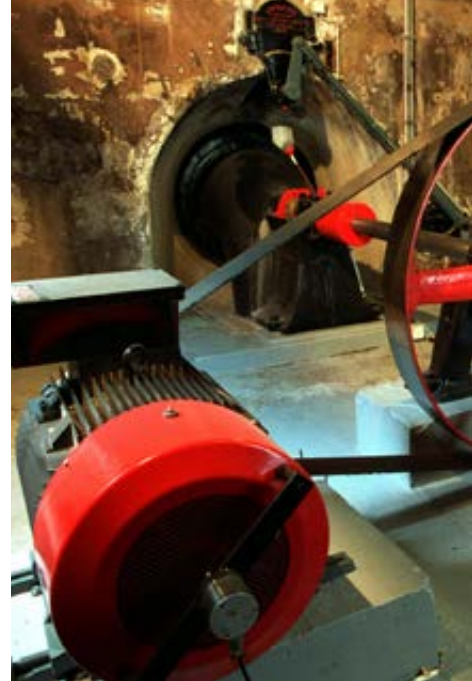
Generator Wasserkraftwerk Trumau © Hans Prammer, Wien Energie
