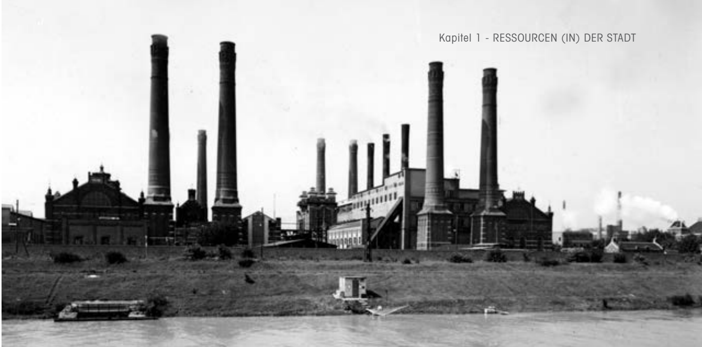
Kraftwerk Simmering 1953 © Wien Energie
