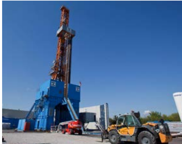
Start der Bohrung, Geothermieanlage Aspern © Wien Energie
