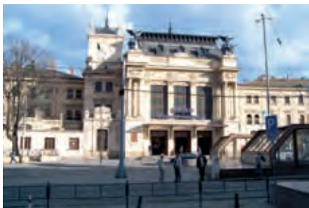
Bestehender Hauptbahnhof, errichtet 1902-1904
