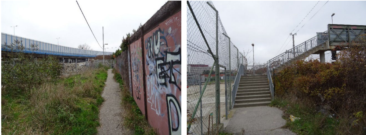
Abbildung 21 Zugang und Übergang der Ost-Bahntrasse Geierecksteg
