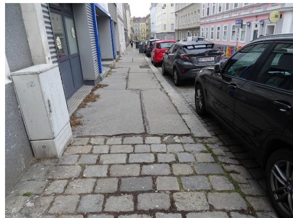
Abbildung 24 Instandhaltung taktiles Leitsystem, Stolperfalle, z.B. Elterleinplatz und Leopold-Ernst-Gasse
