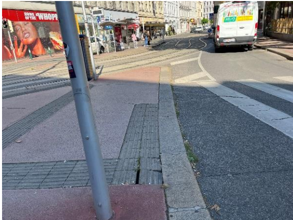
Abbildung 24 Instandhaltung taktiles Leitsystem, Stolperfalle, z.B. Elterleinplatz und Leopold-Ernst-Gasse
