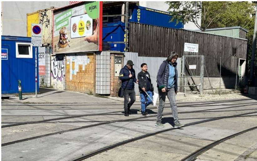
Abbildung 27 Fehlendes taktiles Leitsystem und akustisches Warnsignal auf dem Weg zur integrativen Schule, Hernalser Hauptstraße
