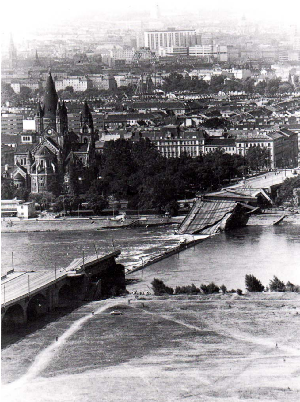
Abb. 38: Die eingestürzte Reichsbrücke. Quelle: 150 Jahre Wiener Stadtbauamt, Seite 140
