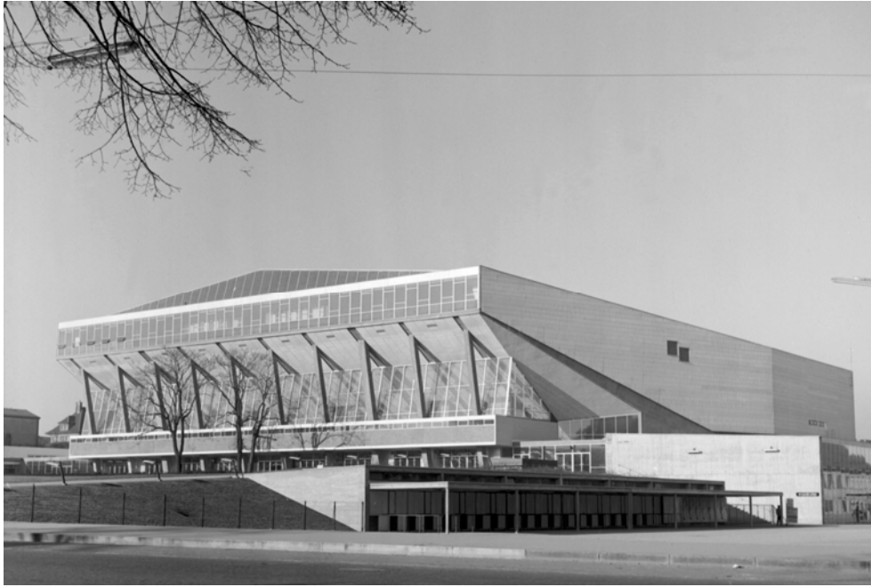
Abb 22: Stadthalle, Quelle: Presse und Informationsdienst der Stadt Wien
