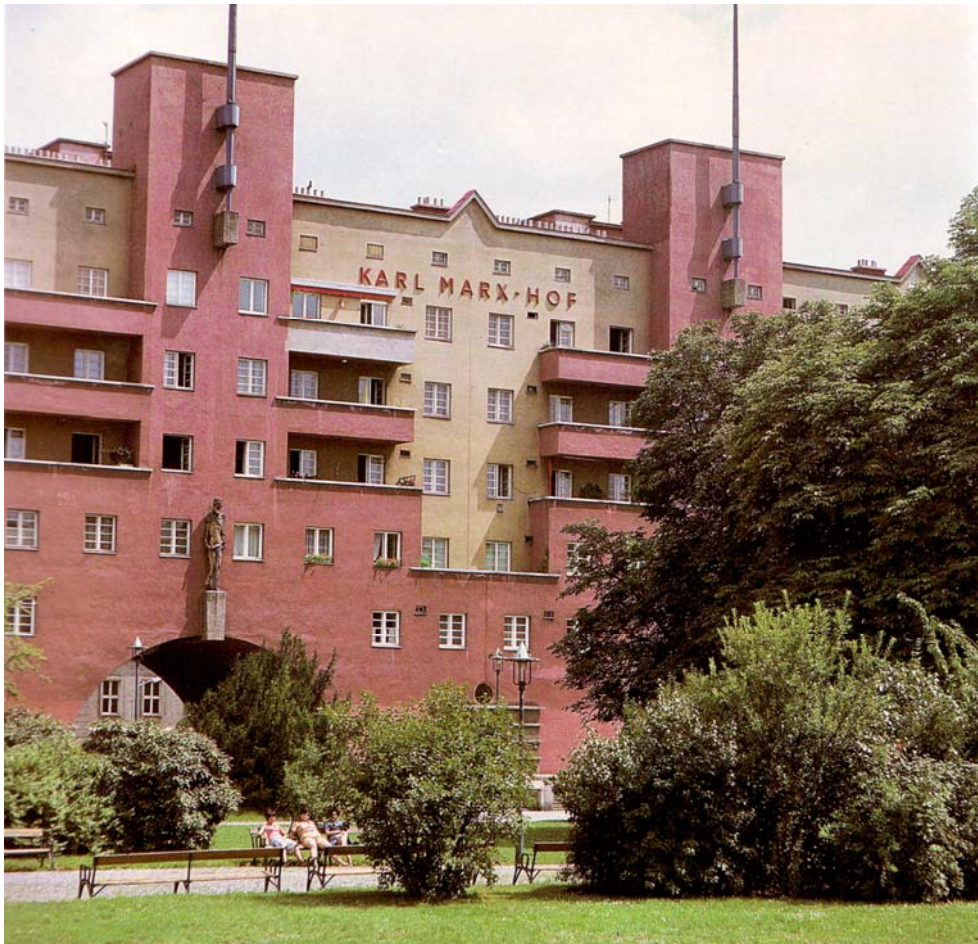
Abb. 11: Der Karl-Marx-Hof, erbaut 1927-30, wurde zum Symbol des sozialen Wohnbaus. Quelle: 150 Jahre Wiener Stadtbauplatz, Seite 30
