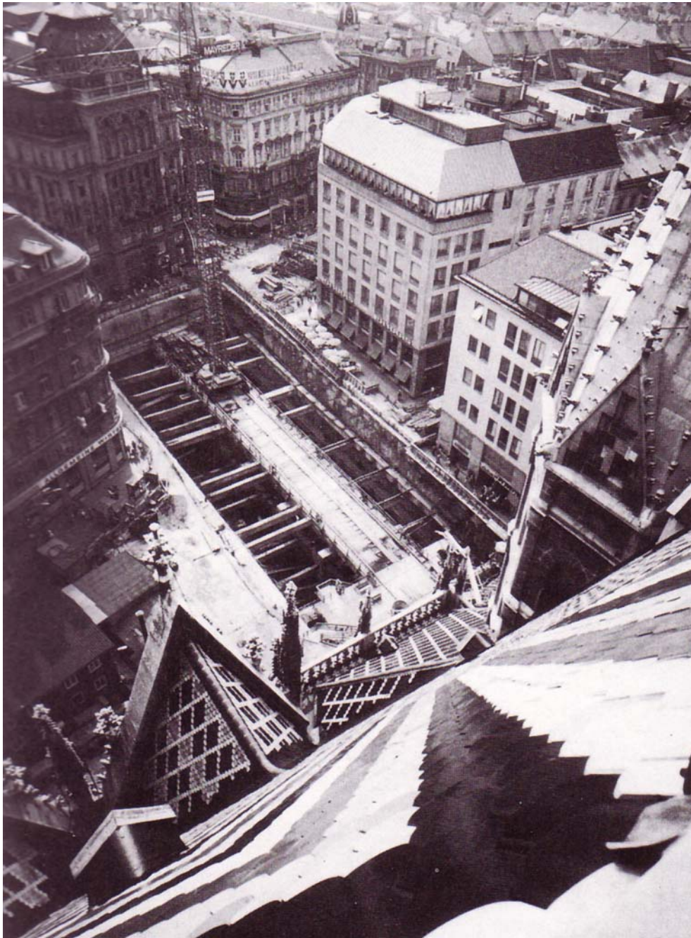
Abb. 31: Gigantische Baugrube für die U-Bahn neben dem Stephansdom. Exakte Detailplanung mit dem obersten Gebot: Sicherheit für den Dom.
