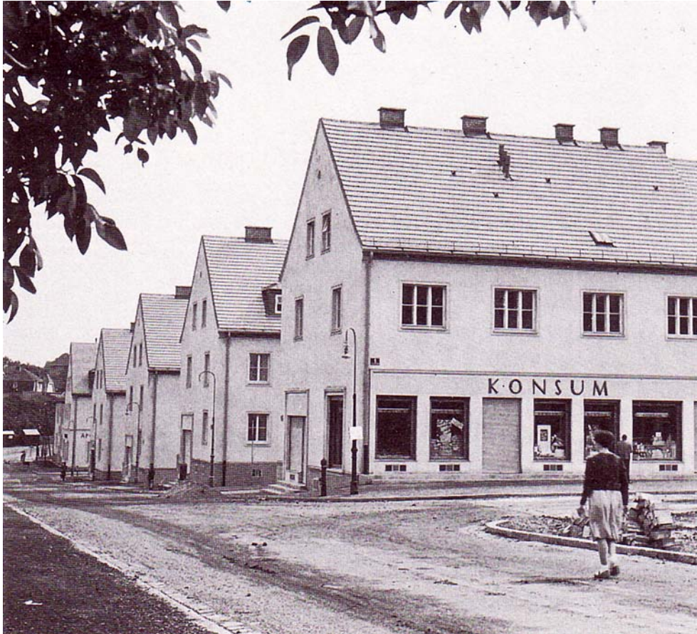
Abb. 18: Die Kongresssiedlung in Hietzing 1953 verband wesentlich verbesserten Komfort mit dem Bemühen, möglichst billig und schnell viele Wohnungen zu bauen. Quelle: 150 Jahre Wiener Stadtbauamt, Seite 105
