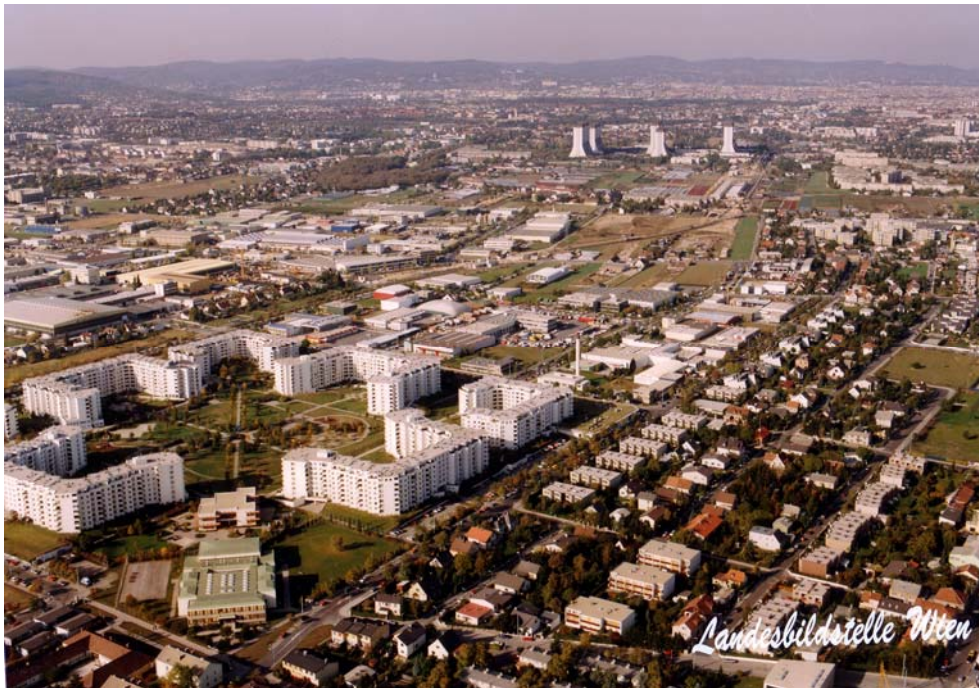
Abb. 24: Die Wohnanlage Wiener Flur als Beispiel für Stadterweiterung durch eine Gartenstadt. Quelle: media wien
