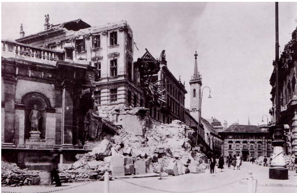
Abb. 13: Die von Bomben zerstörte Albertina im Jahre 1945.
