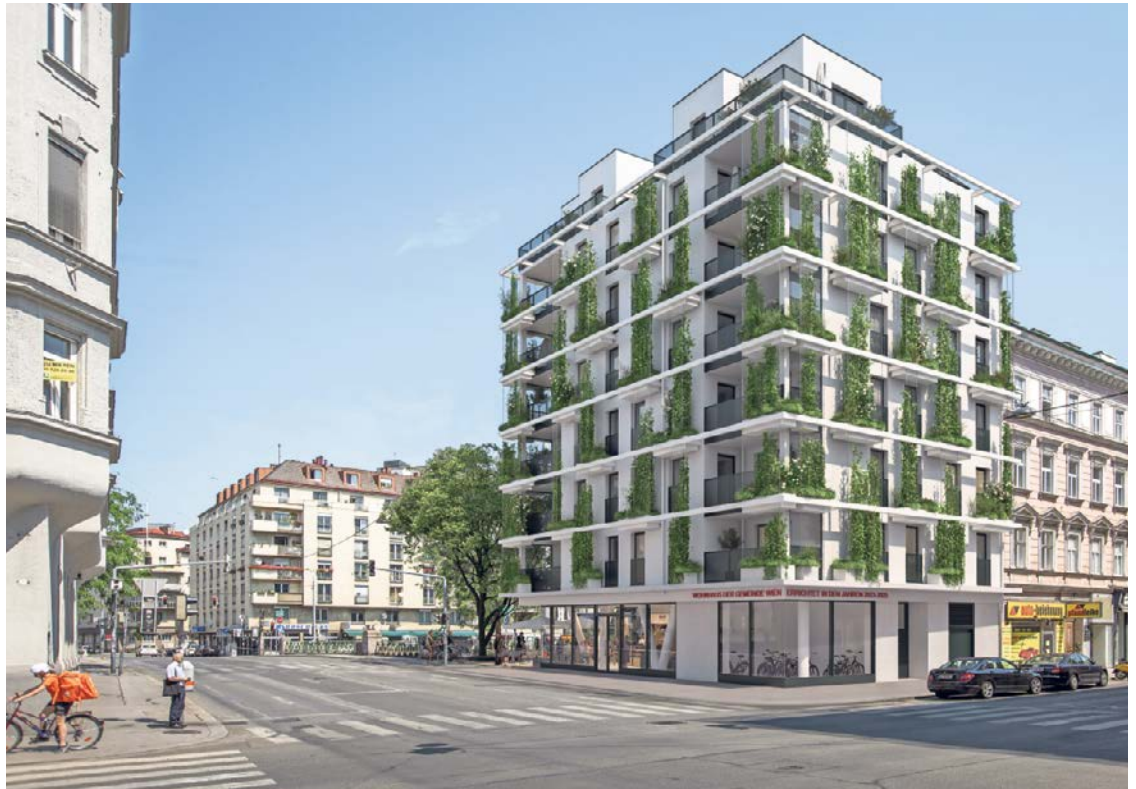
Ein ökologischer Gemeindebau mit acht Stockwerken und vertikalen Fassaden- und Dachbegrünungen entsteht derzeit in Margareten. Ein komplexes Heizsystem versorgt das Niedrigstenergiehaus.
