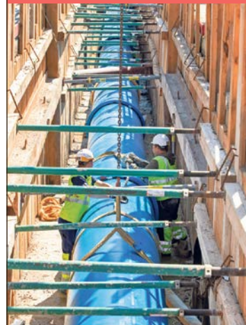
Im Westen Wiens entsteht eine neue Trinkwasserleitung.
