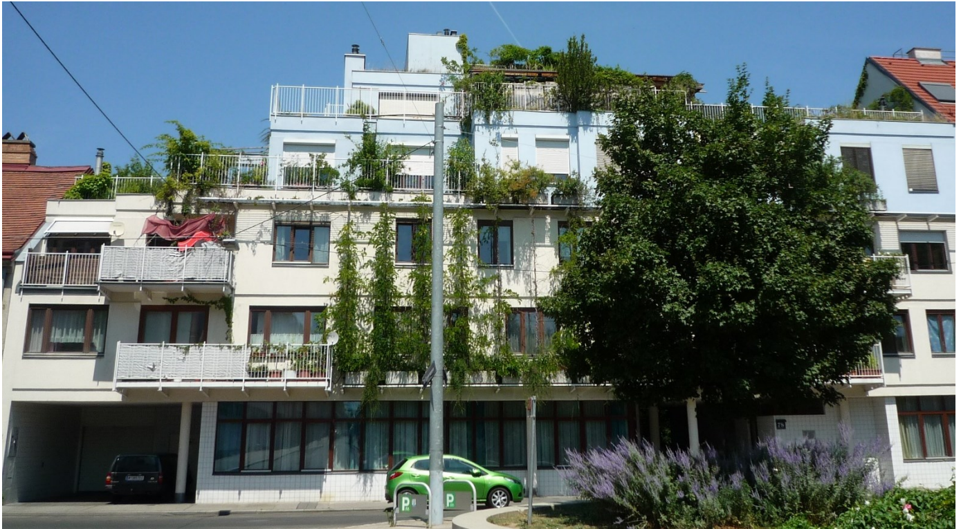
Fassadenansicht © B.R.O.T. Haus Hernals
