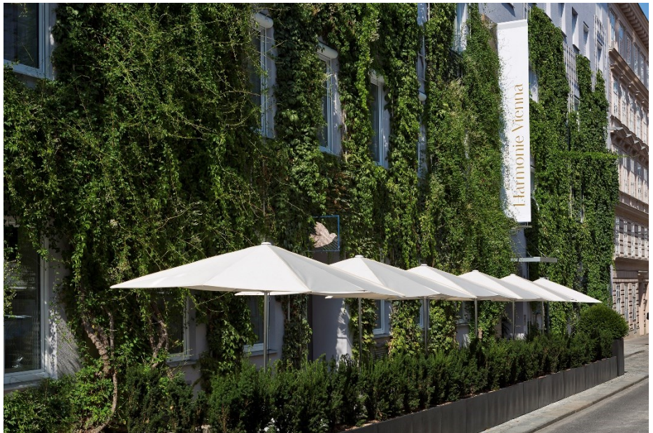
Schrägsicht Fassade © Catherine Stukhart
