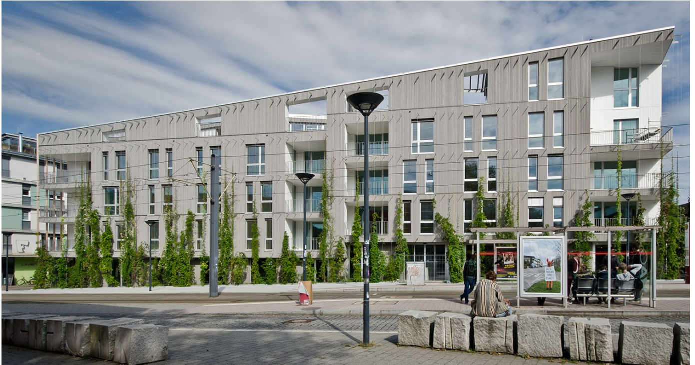
Gesamtansicht Fassade © Barkow Leibinger
