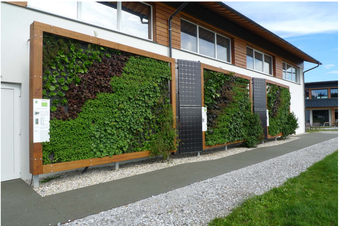
Fassadenbegrünung in Holzrahmen mit PV Modulen © Uli Pitha
