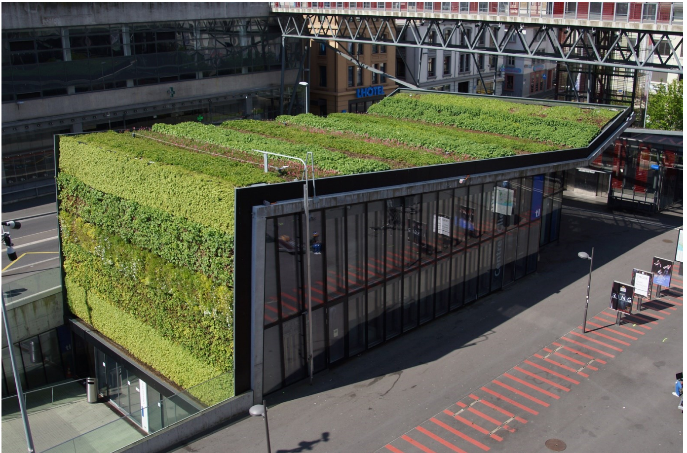
Blick von oben auf m2 Metro Station Lausanne © Nicolas Janberg_www.structurae.de
