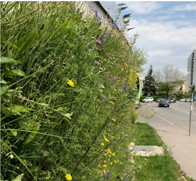
Detailausschnitt der begrünter Fassade – MOL Tankstelle © Vera Enzi/GRÜNSTATGRAU
