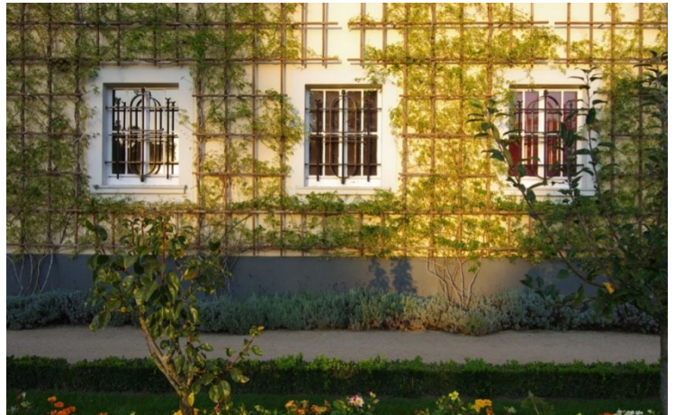
Fassadenansicht frontal im Abendlicht © Nicole Pfoser
