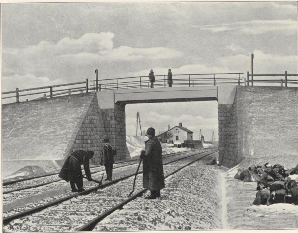
Hergestellt in armiertem Beton System Ast & Co. (verbessertes System Hennebique).
