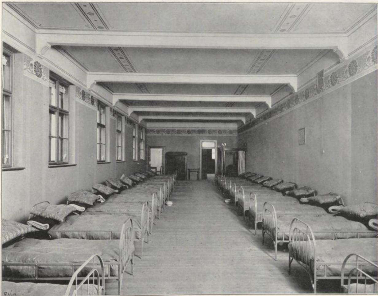
Sämtliche Decken- und Stiegenkonstruktionen in armiertem Beton. Gesamtausmass 10.000 m<sup>2</sup>.
