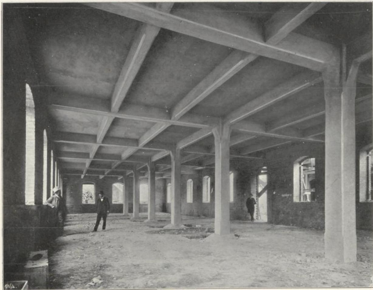
Sämtliche Decken, Säulen und Dächer in armiertem Beton System Ast & Co.
