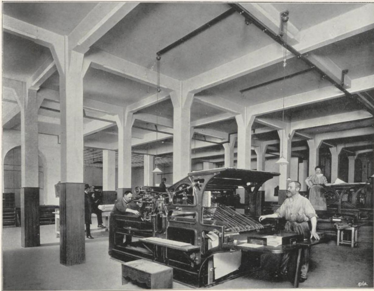
I. Stock. Decken und Säulen in armiertem Beton, gerechnet für eine Nutzlast von 1000 kg per  $m^2$ .
