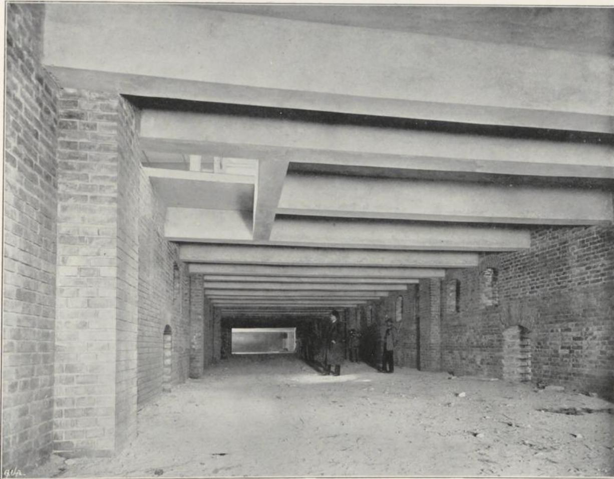
Diese Decke hat 7·5 bis 10·6 m Spannweite und trägt Nutzlasten von 1500 kg pro m<sup>2</sup>.
