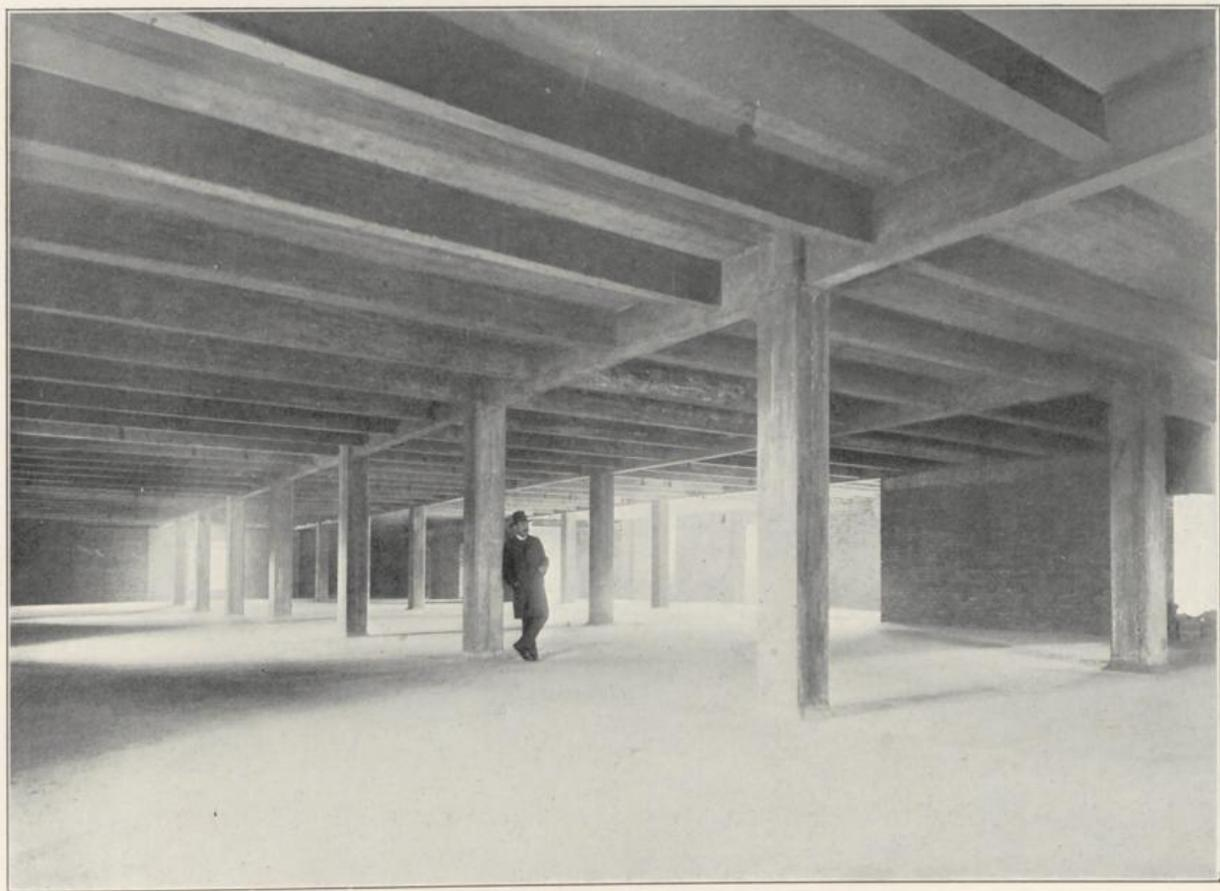
Decken und Säulen in armiertem Beton. Gerechnet für eine Nutzlast von  $800\text{ kg per } m^2$ . Gesamtausmass ca.  $5000\text{ m}^2$ .
