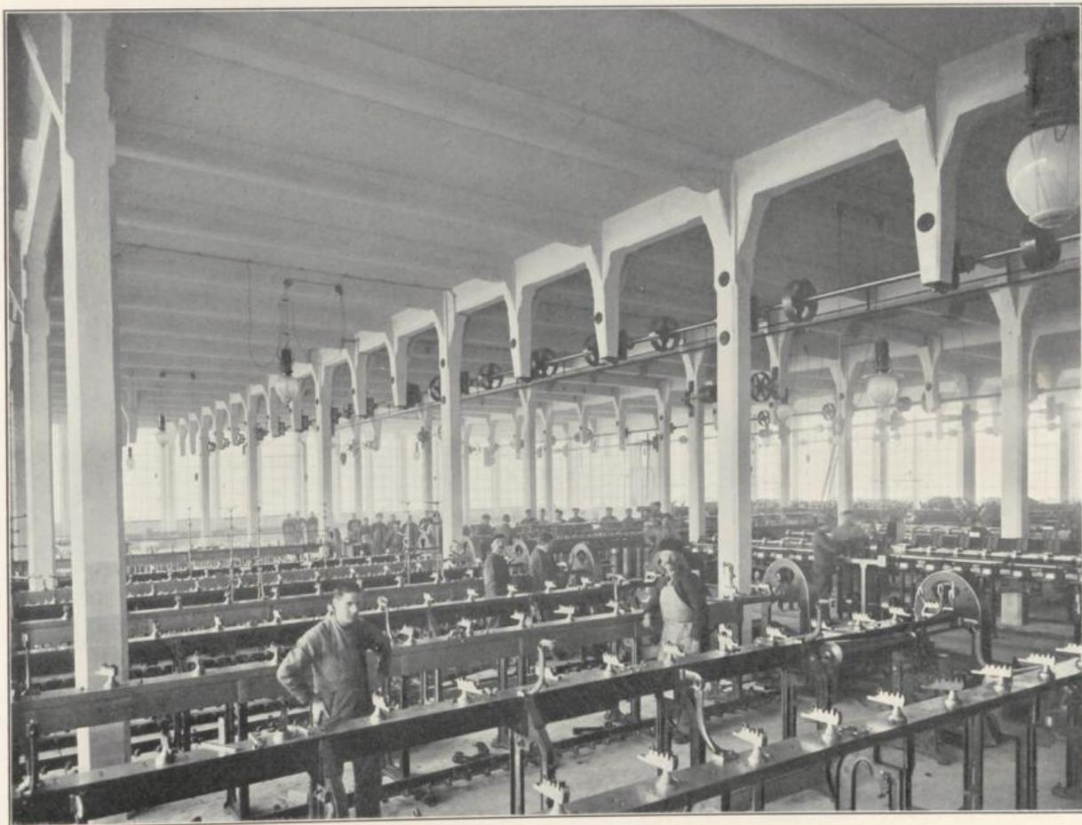
Wände, Säulen, Decken — alles in armiertem Beton. Bausumme 300.000 Mark.
