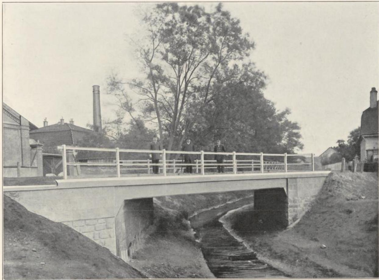
Gerechnet für 12 tons-Wagen, Spannweite 10 m.
