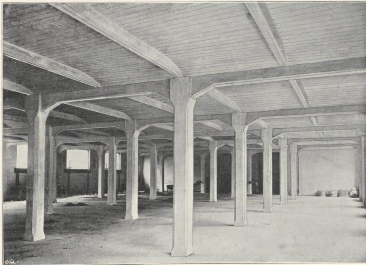
Ausgeführt in armiertem Beton.
