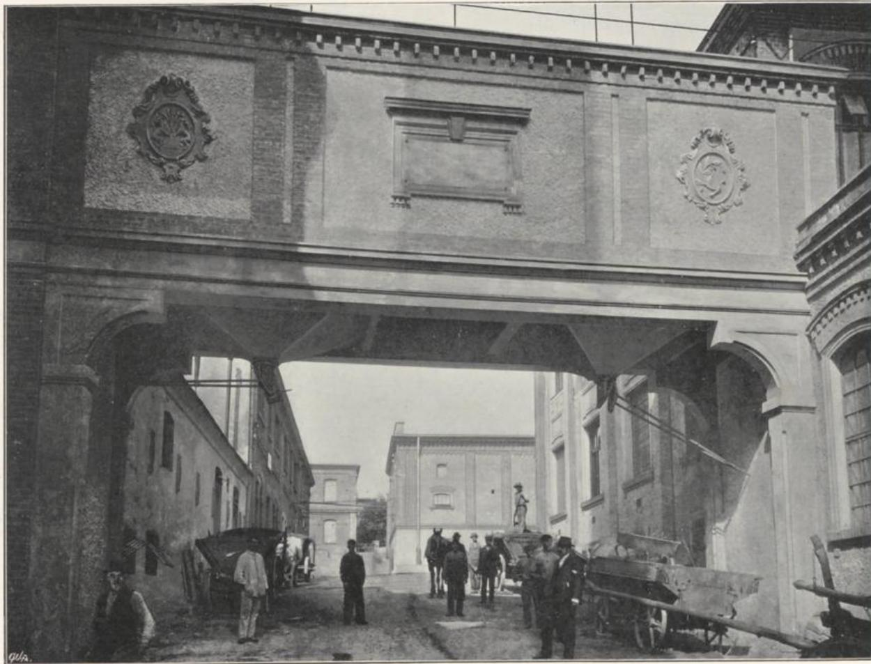
Ausgeführt im Auftrage der Herren Medinger & Bachofen ganz in armiertem Beton.
