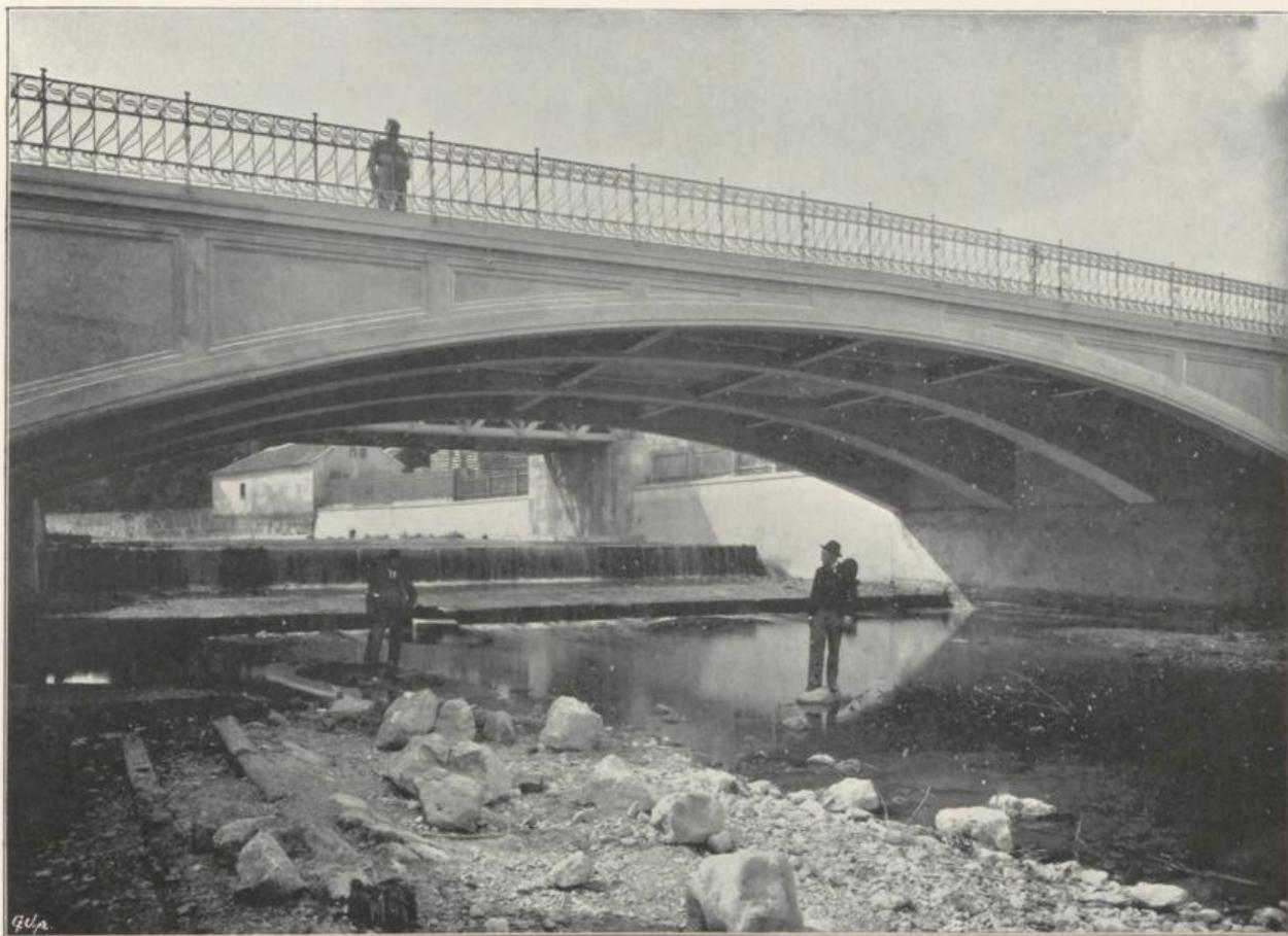
12,0 m breit, 23,7 m Spannweite, gerechnet für 12 tons-Wagen.
