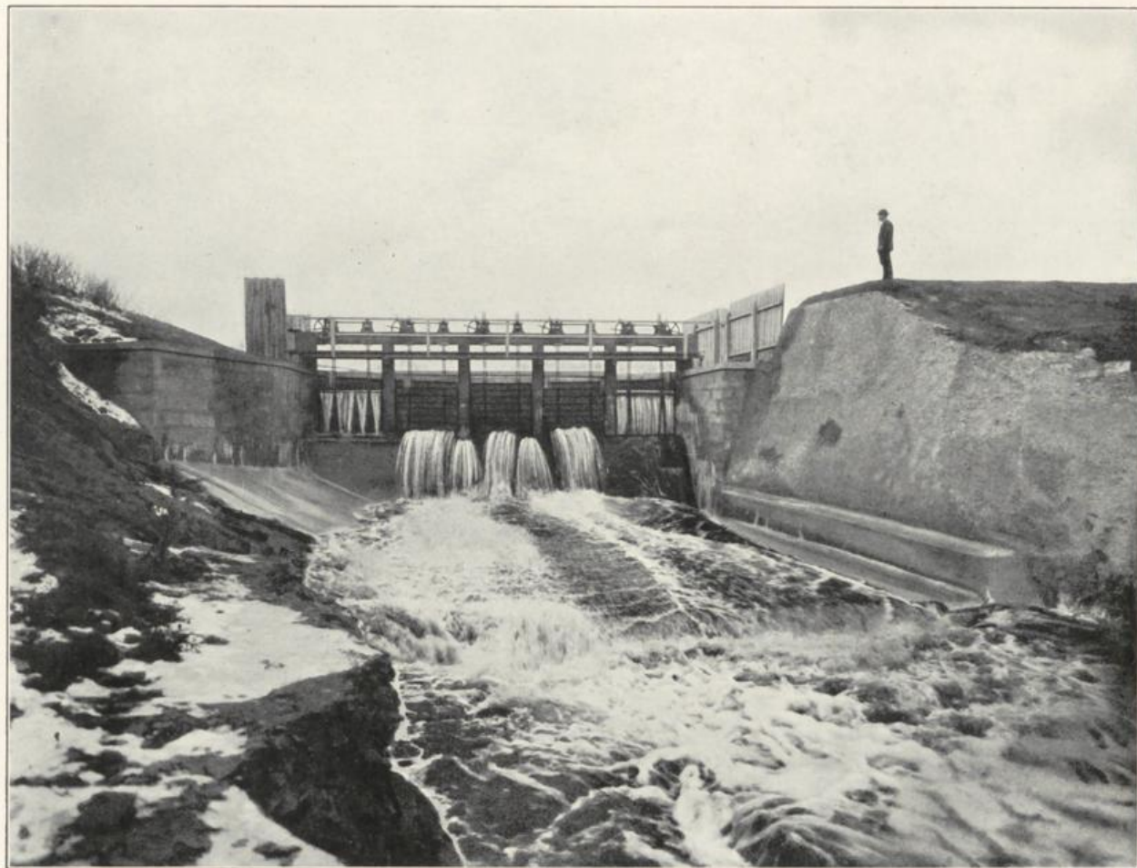
Griessäulen und Steg aus armiertem Beton System Ast & Co. Pläne und Disposition der Anlage aus dem Bureau der Firma Ed. Ast & Co. Bauherr: Markgräfllich Pallavicinische Gutsverwaltung in Jamnitz.
