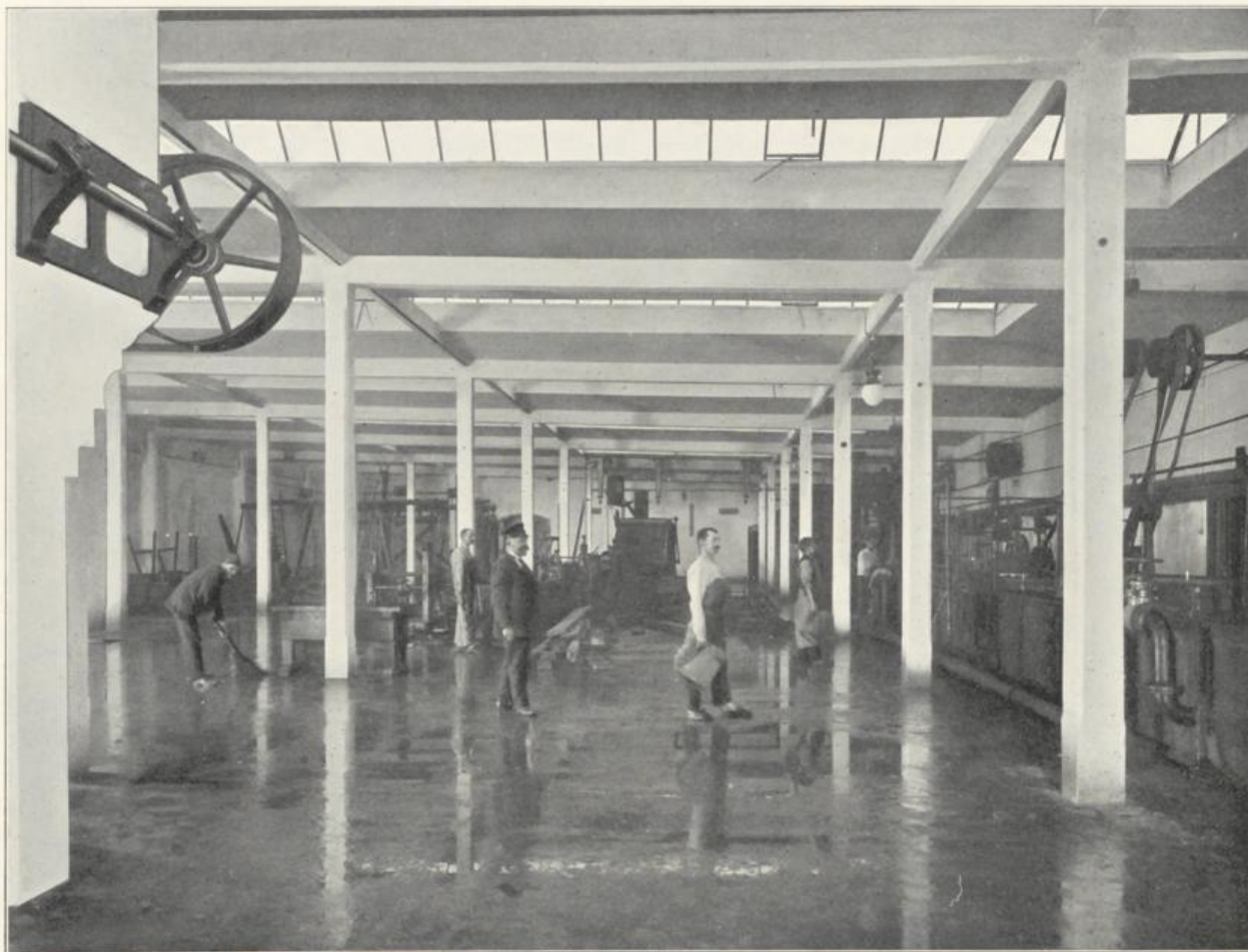
1300 m 2 . Oberlichtweite 2'0 m. Säulenhöhe 4'5 m. Säulendistanzen 6'2/6'0 m. Shedbau aus armiertem Beton System Ast & Co.
