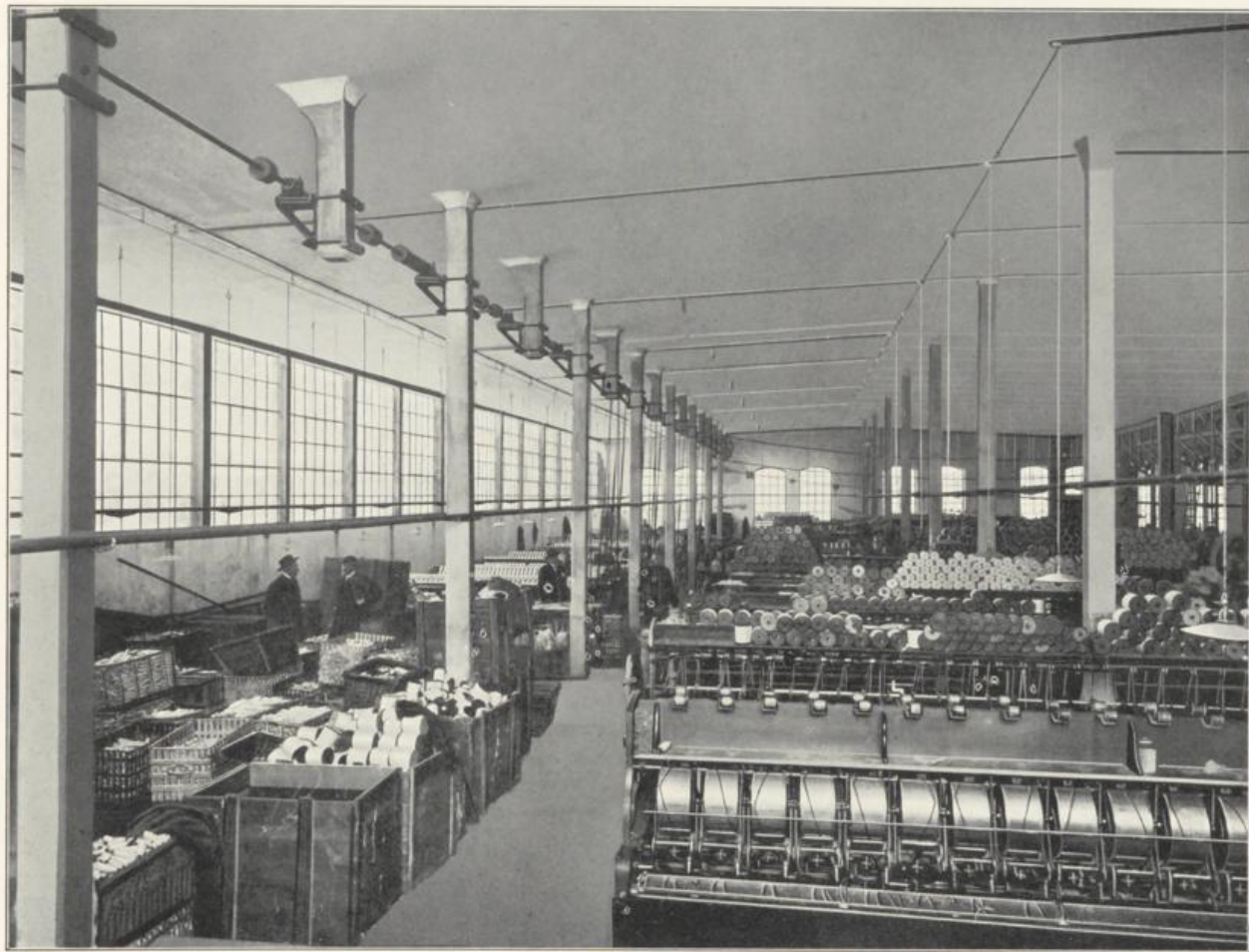
Konstruktionen aus armiertem Beton. Säulen, Hängesäulen und Dach nach den Plänen der Firma Ed. Ast & Co. 1500 m 2 . Säulenhöhe 5,5 m. Säulenstärke 18/18 cm.
