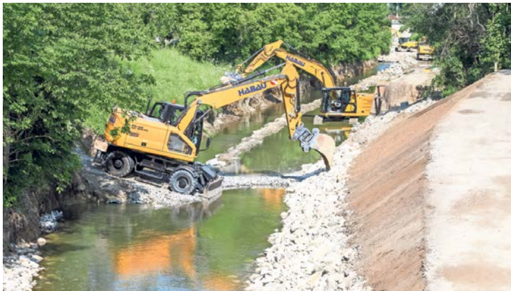
Das hart verbaute Flussbett des Liesingbachs wird sukzessive aufgebrochen.
