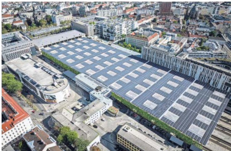
Auf dem Dach des Westbahnhofs wird Sonnenenergie gesammelt.
