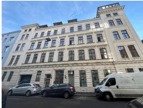
Abbildung 9: Ansicht der Nordwestfassade der Liegenschaft in der Dianagasse (BOKU).
