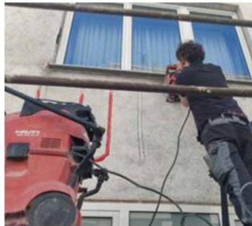
Abbildung 11: Heizungsrohre in der Außenwand, vor Herstellung der Wärmedämmung. (Quelle: (Holzer & Müller, 2022))
