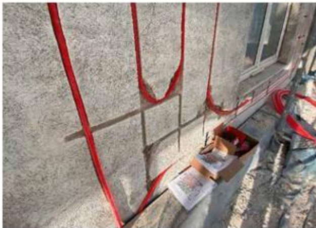
Abbildung 11: Heizungsrohre in der Außenwand, vor Herstellung der Wärmedämmung. (Quelle: (Holzer & Müller, 2022))
