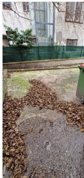
Innenhof, Bildquelle: HV Steiner
