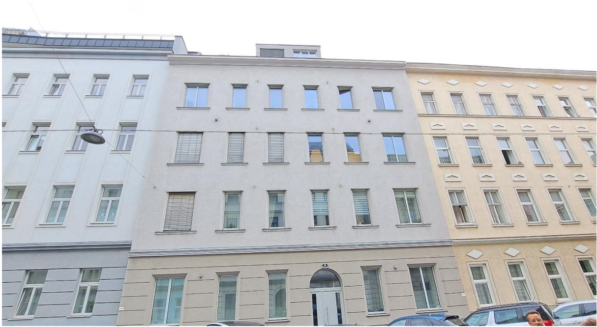
Abbildung 32: Fassade des sanierten Gebäudes in der Eberlgasse 3 im 2. Bezirk. © Stadt Wien/Bojan Schnabl
