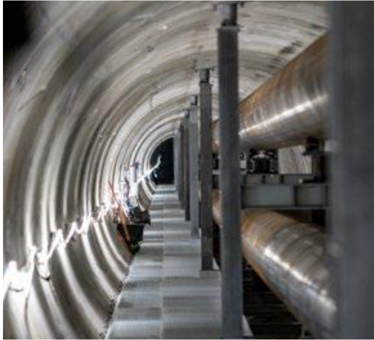
Abbildung 92: Blick in die Fernwärmeleitungen unter der Elbe [7]
