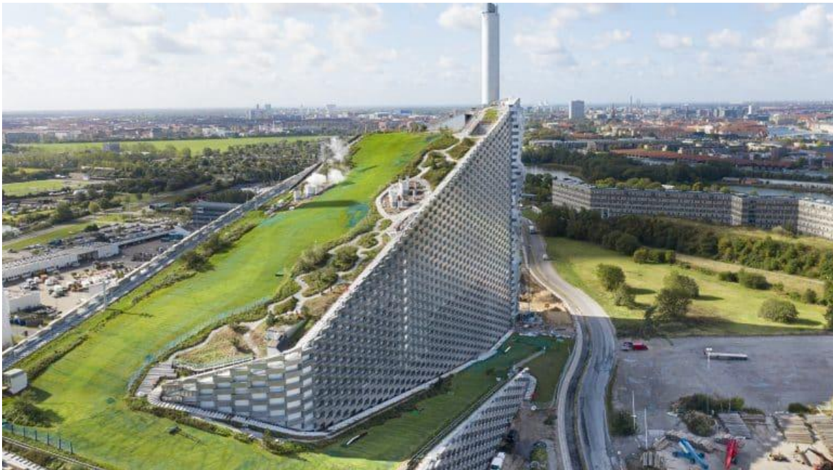
Abbildung 26: Müllverbrennungsanlage „Amager Bakke“ inkl. der Ski-Piste auf dem Dach der Anlage [22]
