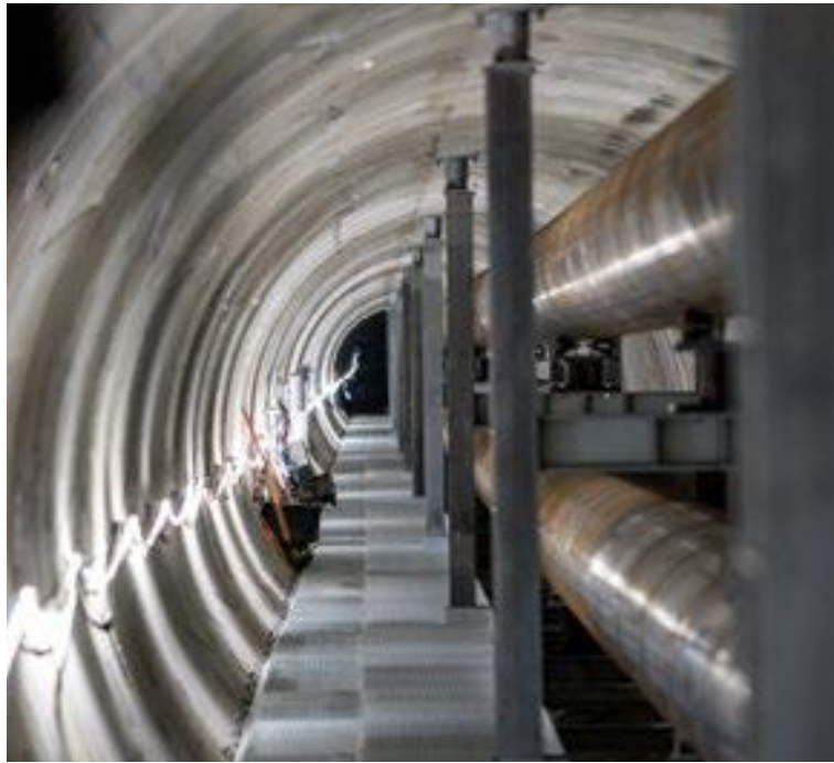
Abbildung 92: Blick in die Fernwärmeleitungen unter der Elbe [7]
