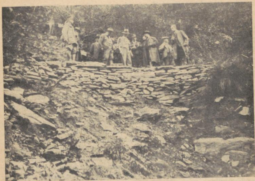
Fig. 3. Der Touristenweg nach Reparatur der Stützmauer. (Aufnahme gelegentlich des Augenscheines vom 14. September 1929.)
