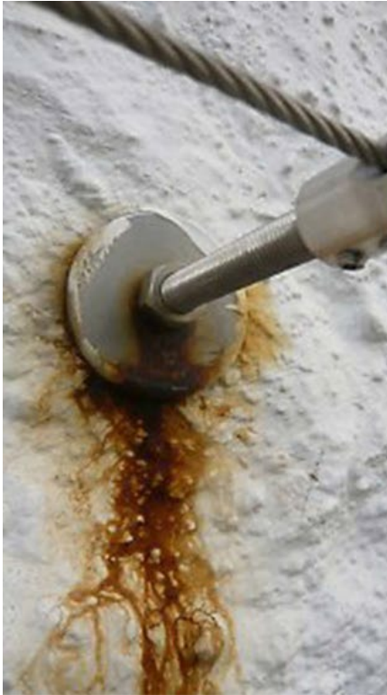
Links: verfärbter Stahl durch rostendes Eisen | © FASSADENGRÜN, Mitte: rostender, verzinkter Wandhalter | © FASSADENGRÜN, rechts: Holz als Kletterhilfe | © Pixabay
