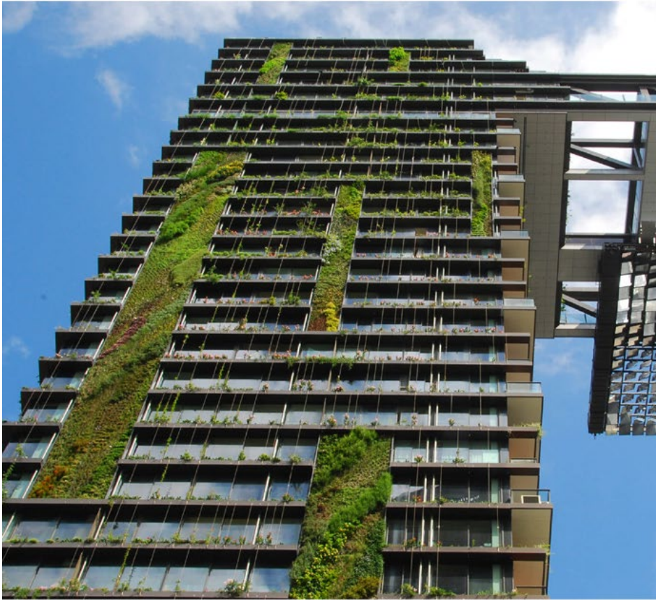
Fassadengebundenes System | vollflächig | Mischform Trog mit Kletterhilfe | © CC BY 2.0 | ROB DEUTSCHER | flickr.com
