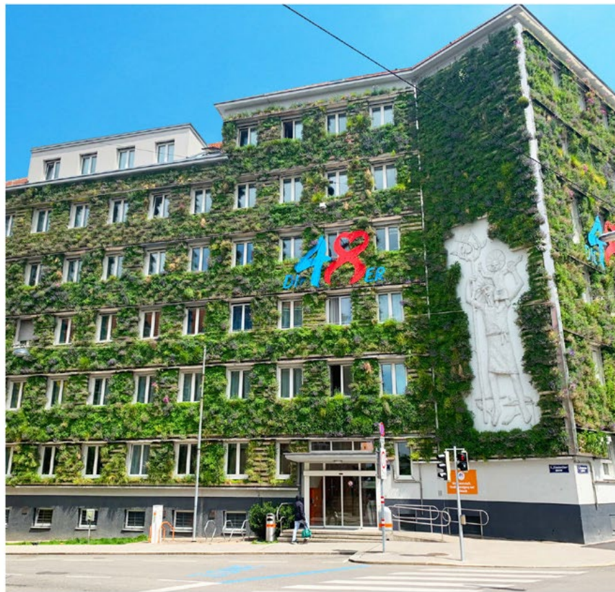
Teilflächiges Baukastensystem / linear / © GREEN4CITIES
