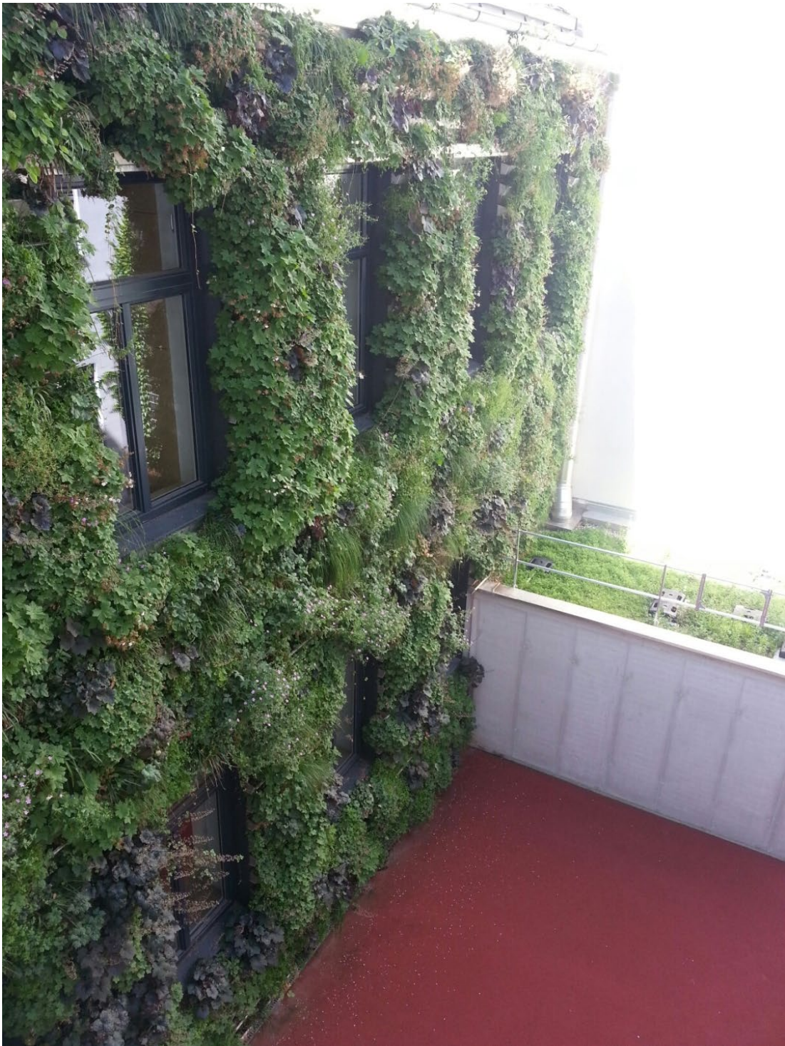
Fassadengebundene Begrünung / teilflächiger Vegetationsträger / linear / < 50 cm Abstand / © GRÜNWAND
