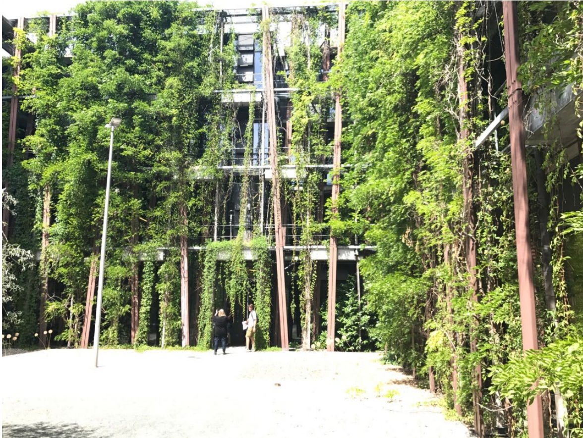
Fassadengebundene Begrünung / teilflächiger Vegetationsträger / punktuell / © GREEN4CITIES
