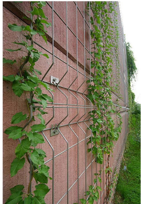
Links: bodengebundene Begrünung mit starrer, flächiger Kletterhilfe / MFO Park / Zürich / © GREEN4CITIES, rechts: bodengebundene Begrünung mit starrer, flächiger Kletterhilfe / © LEGI
