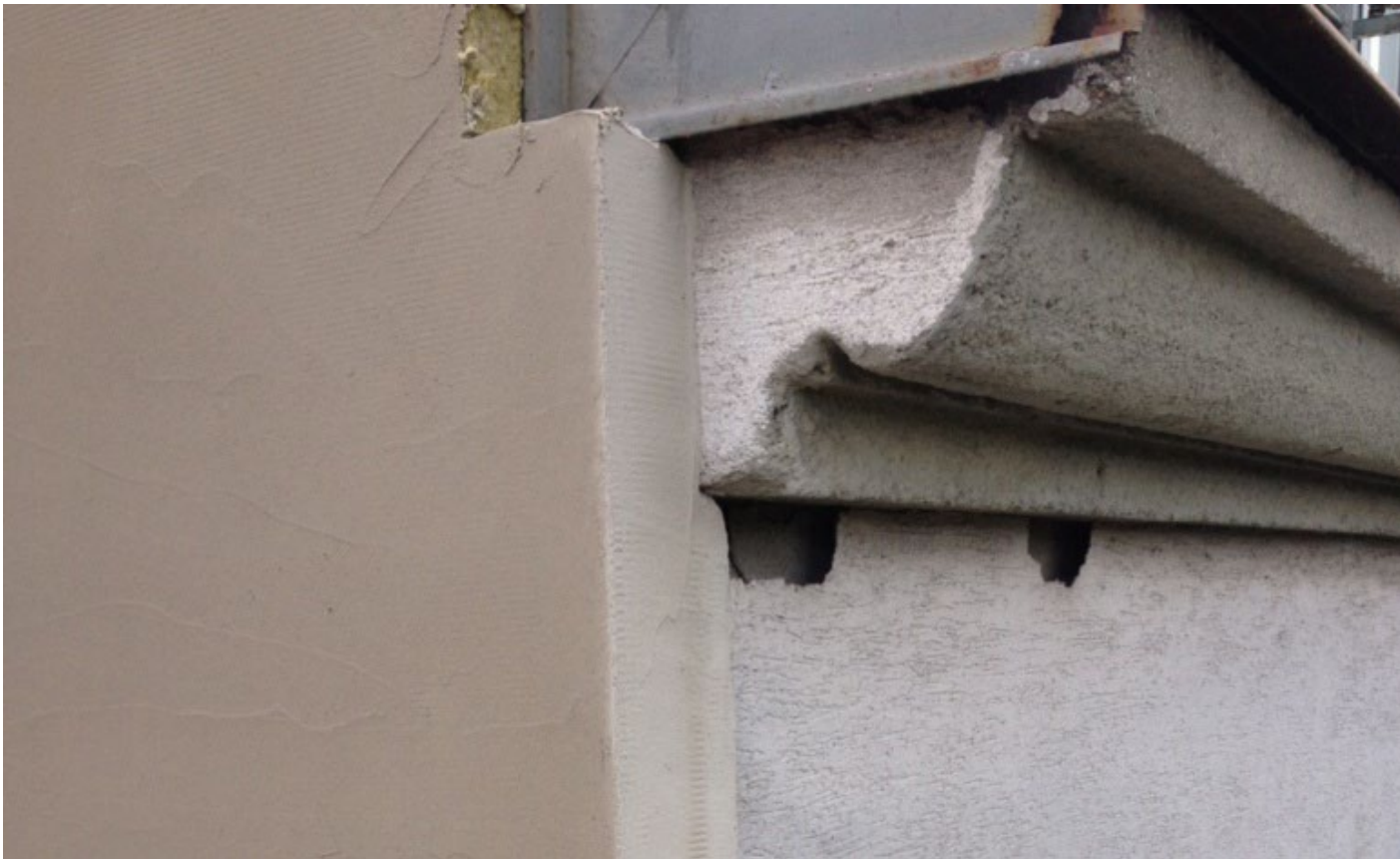
Buntspechtlöcher an Fassade © VLASCHITS
