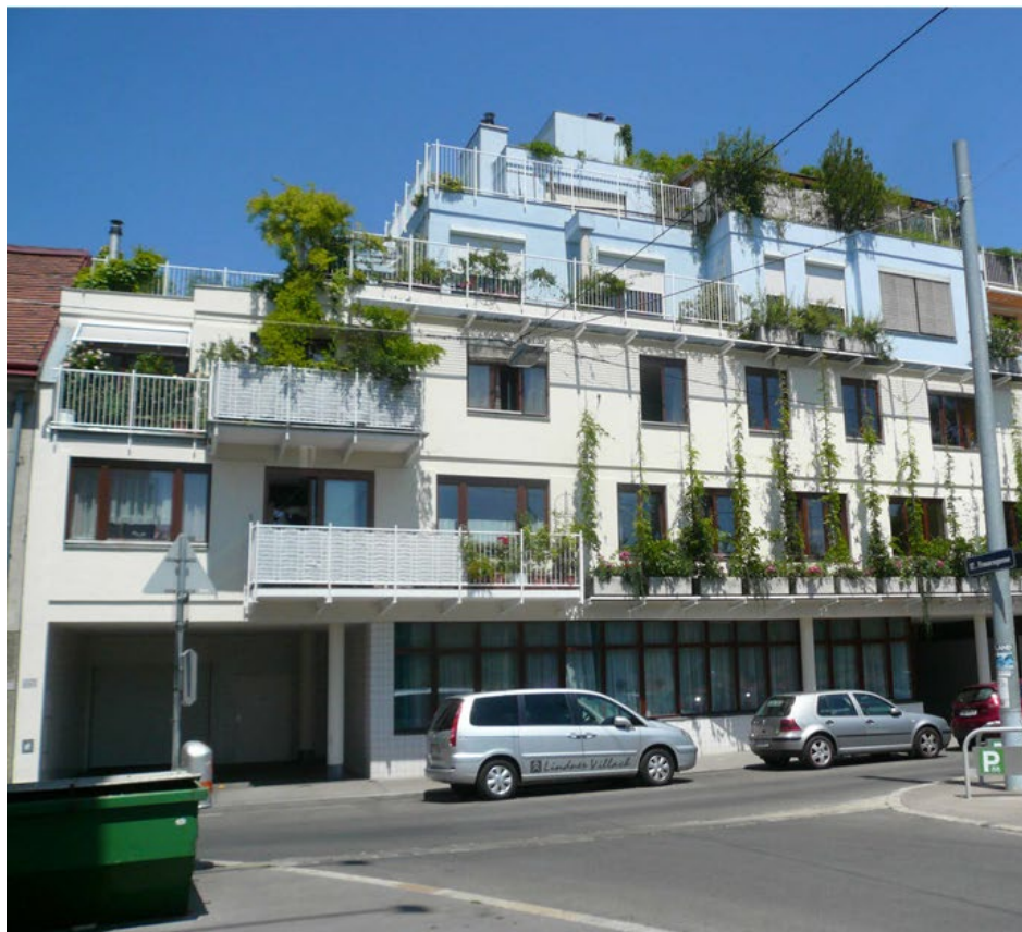
Fassadengebundenes System / Tröge mit Kletterhilfen / Wien / © Vfb
