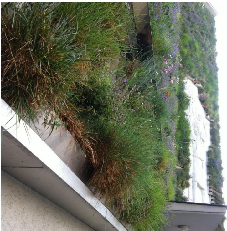
Fassadengebundene Begrünung | Gräser | © GREEN4CITIES
