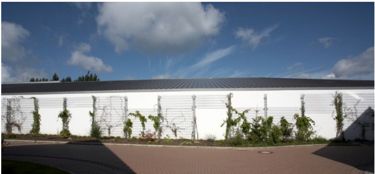
Bodengebundene Begrünung mit starrer, flächiger Kletterhilfe | © LEGI A.2 Mit Kletterhilfe / A.2.1 Starr | A.2.1b Linear
