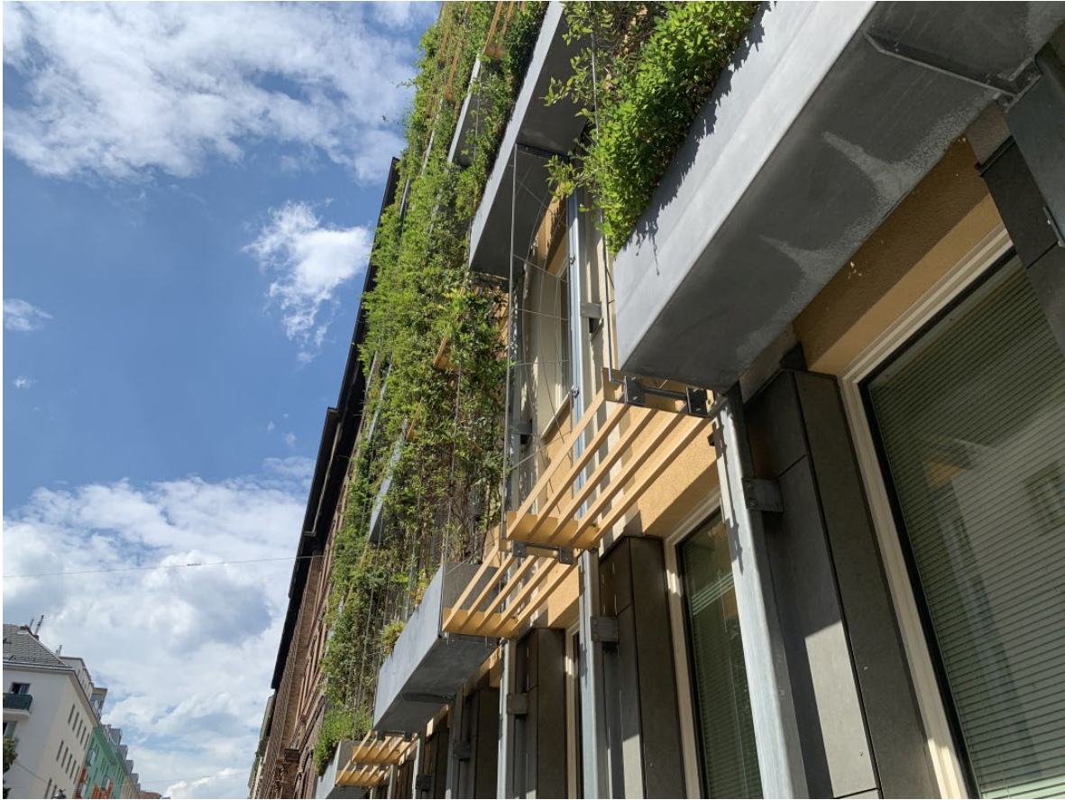
Fassadengebundene Begrünung | teilflächiger Vegetationsträger | punktuell | © GREEN4CITIES
