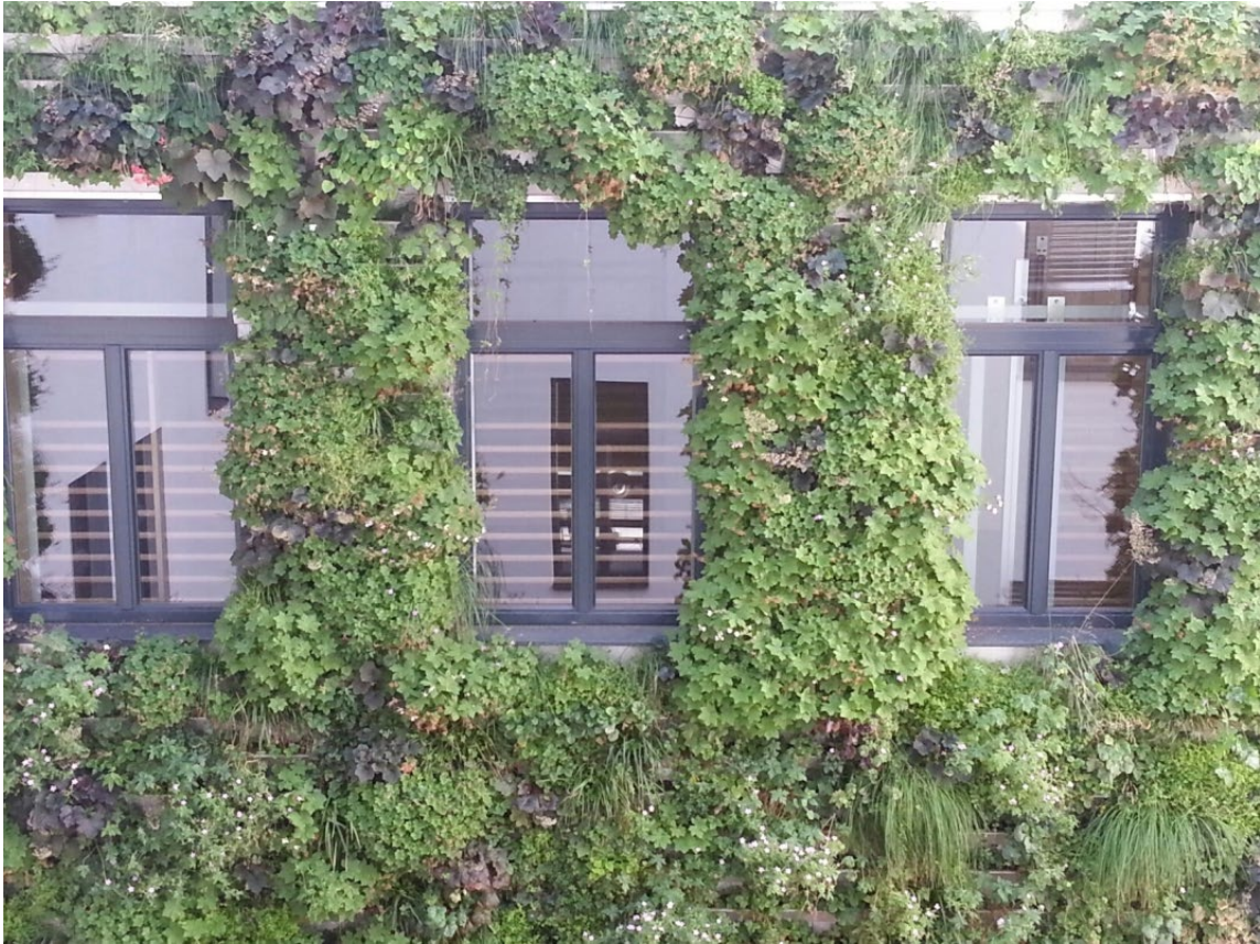
Fassadengebundene Begrünung / teilflächiger Vegetationsträger / linear / < 50 cm Abstand / © GRÜNwand
