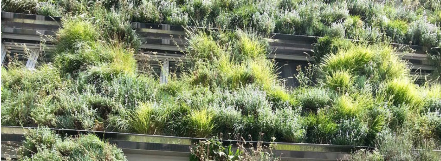
Fassadengebundene Begrünung / teilflächiger Vegetationsträger / linear / < 50 cm Abstand / © GRÜNWAND
