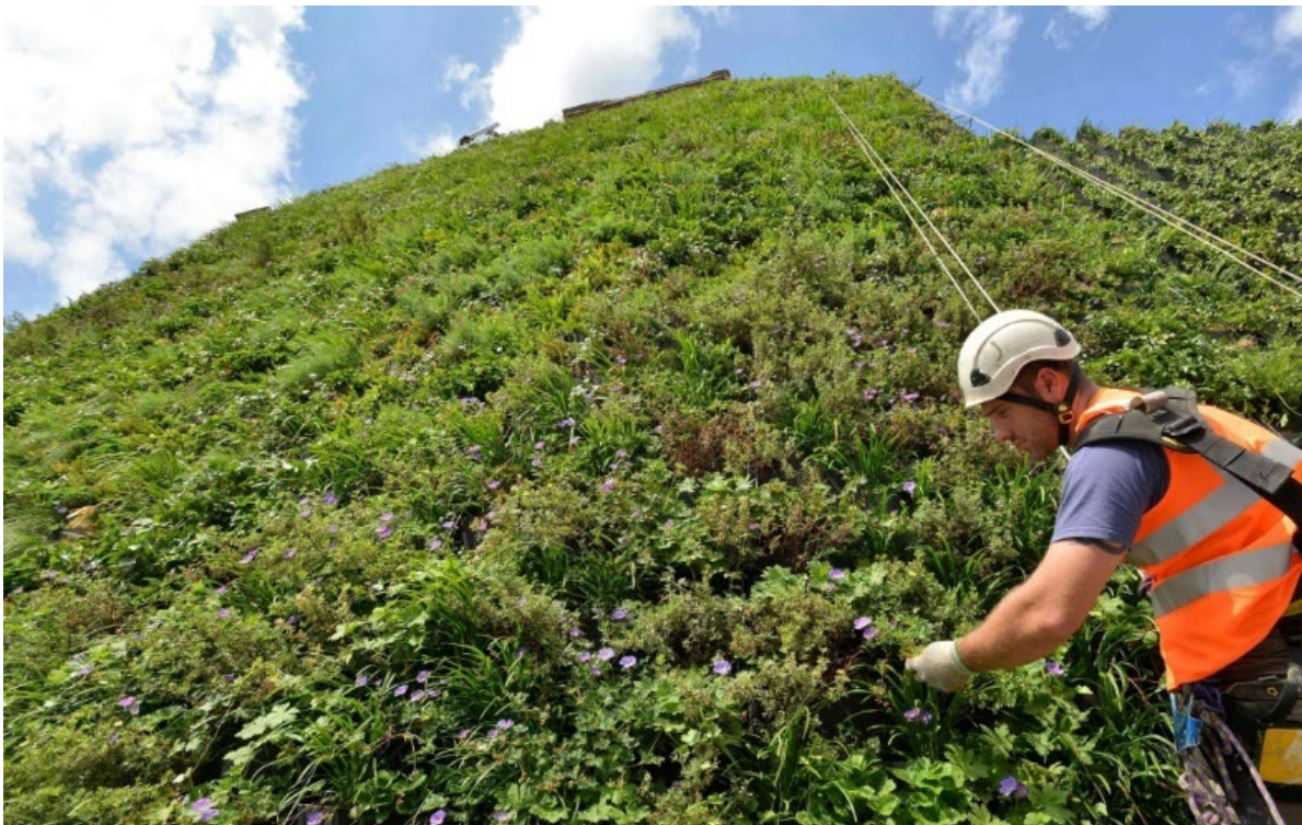
Pflegemaßnahme durch einen Industriekletterer | © RUBENS AT THE PALACE HOTEL
