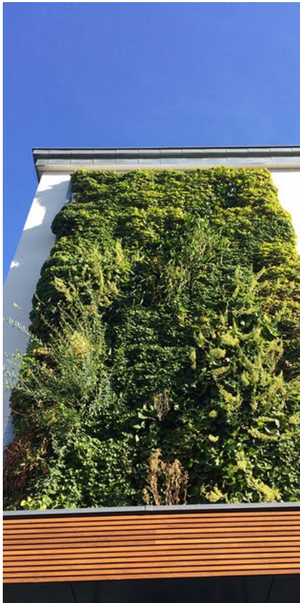
Fassadengebundenes Gesamtsystem | vollflächig | Baden | © 90DEGREEN
