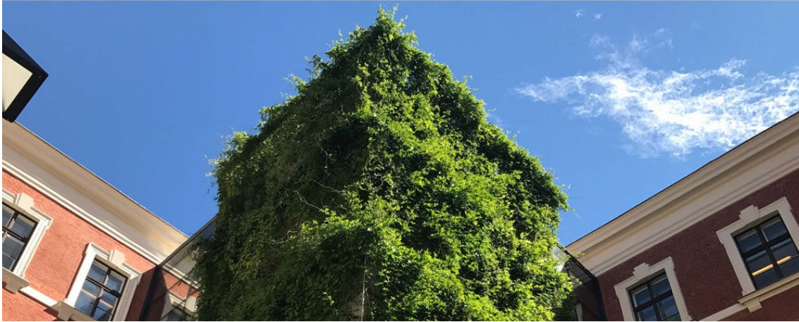
Fassadengebundene Begrünung | teilflächiger Vegetationsträger | linear | > 50 cm Abstand | © GREEN4CITIES
