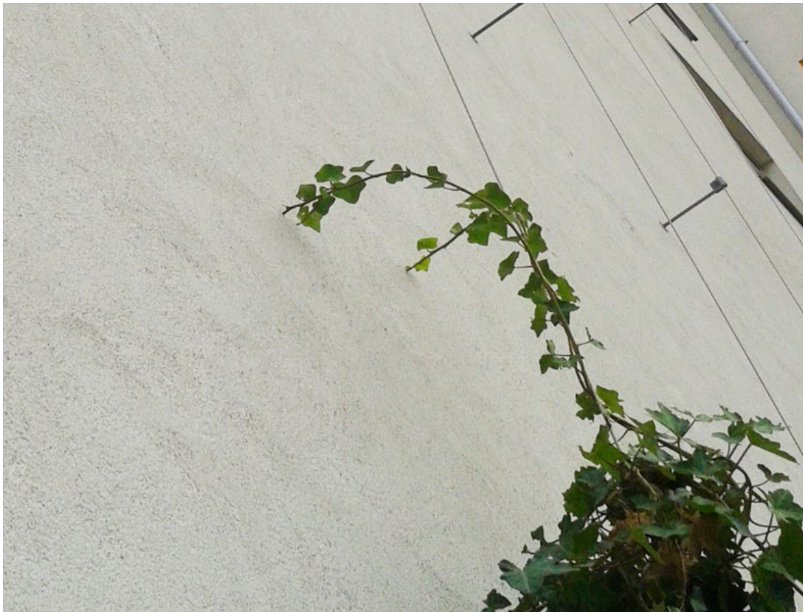
Selbstklimmer (Efeu) plagt sich auf der Kletterseilkonstruktion / © Stadt Wien – Umweltschutz
