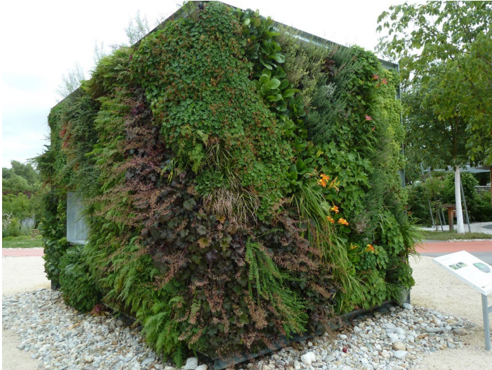
Schutz vor mechanischen Umwelteinflüssen / fassadengebundenes System / LGS Tulln © VfB
