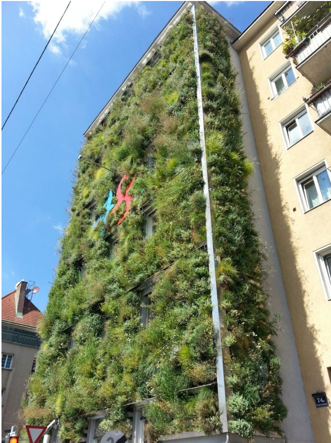
Fassadengebundenes System / südseitige Exposition / MA-48-Fassade / Wien / © VfB
