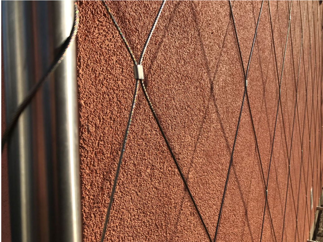
Kletterhilfe / Seilnetz / flexibel / flächig / © GREEN4CITIES
