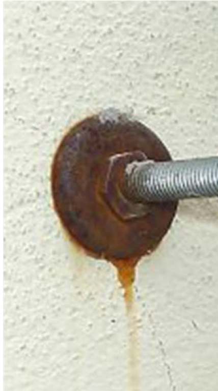
Links: verfärbter Stahl durch rostendes Eisen | © FASSADENGRÜN, Mitte: rostender, verzinkter Wandhalter | © FASSADENGRÜN, rechts: Holz als Kletterhilfe | © Pixabay
