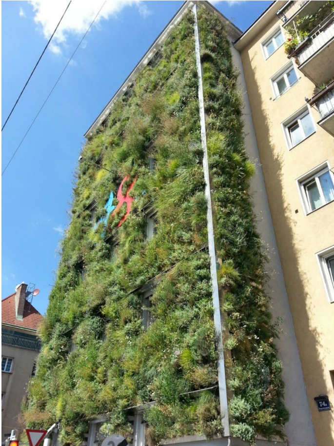
Fassadenbegrünung des Gebäudes der Stadt Wien – Abfallwirtschaft, Straßenreinigung und Fuhrpark („MA48-Grünfassade“) © GREEN4CITIES
