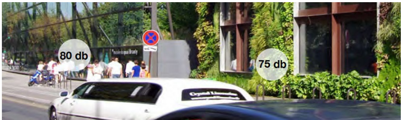
Schallreduktion durch Fassadenbegrünung, Musée du Quai Branly Paris © PFOSER, 2011
